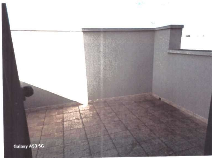
FOTO 17 Terrazzino al Piano Secondo
