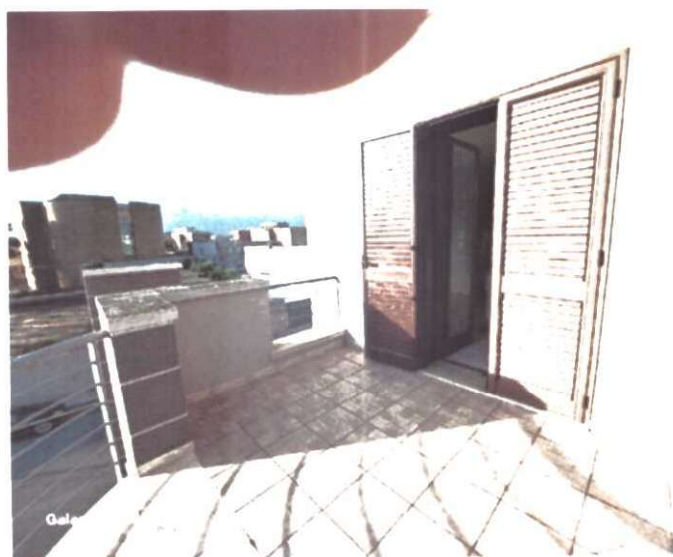
FOTO 16 Balcone al Piano Secondo
