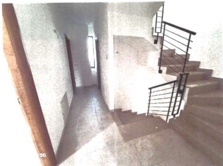
FOTO 9 Disimpegno Piano Primo
