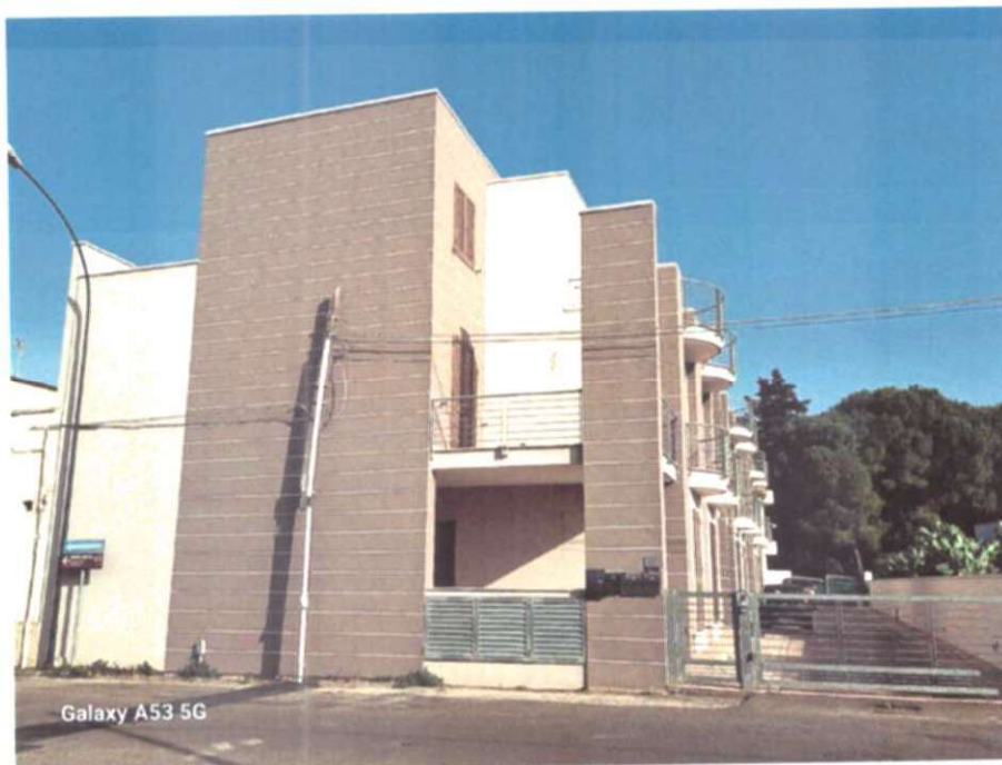
FOTO 1 – Prospetto laterale su via Sant’Elia
