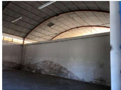
INTERNO CORPO "D"
