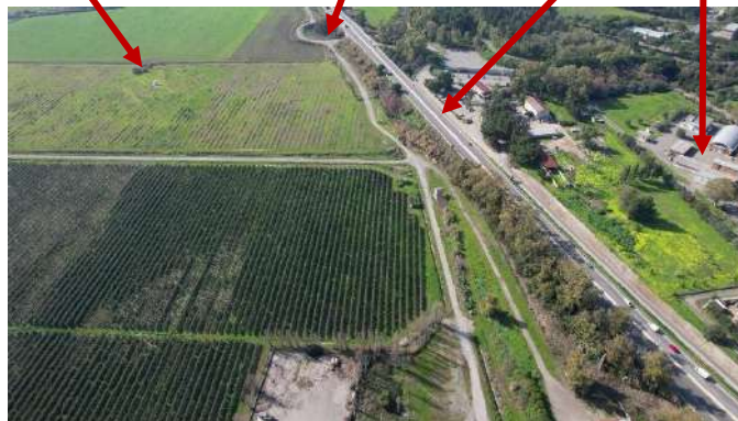
FOTO AEREA CON DRONE POZZO RIVOLTA1 SVINCOLO SS. 106- SS. 106
