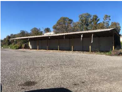
TETTOIA CORPO "C"
