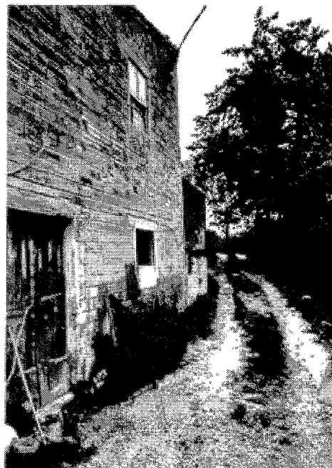
Particolare del prospetto
