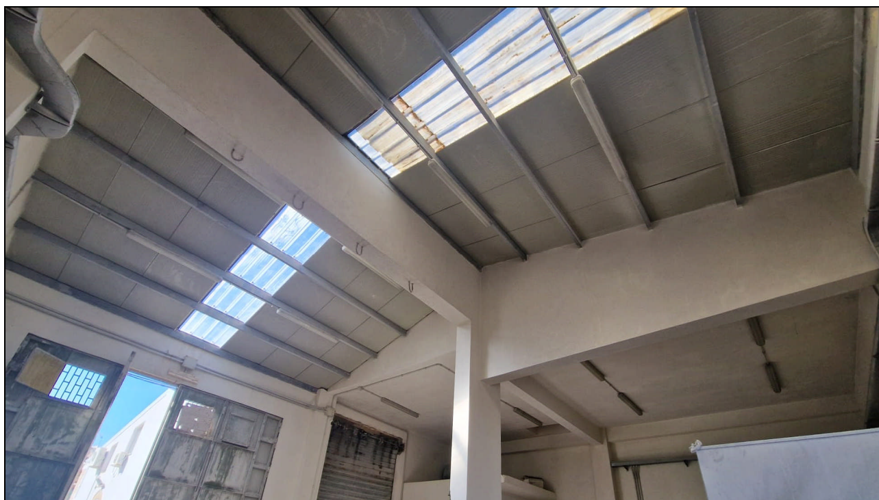
Foto 8: Particolare copertura locale Laboratorio
