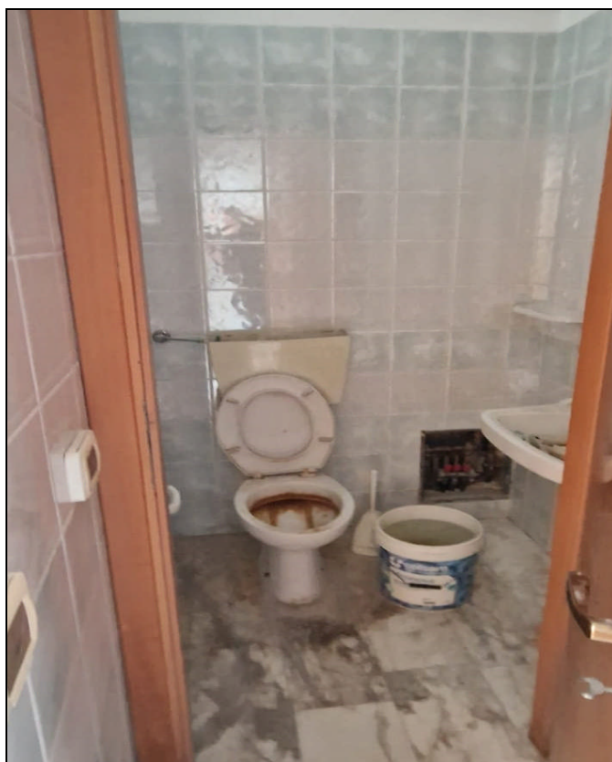
Foto 10: Particolare interno vano w.c..
