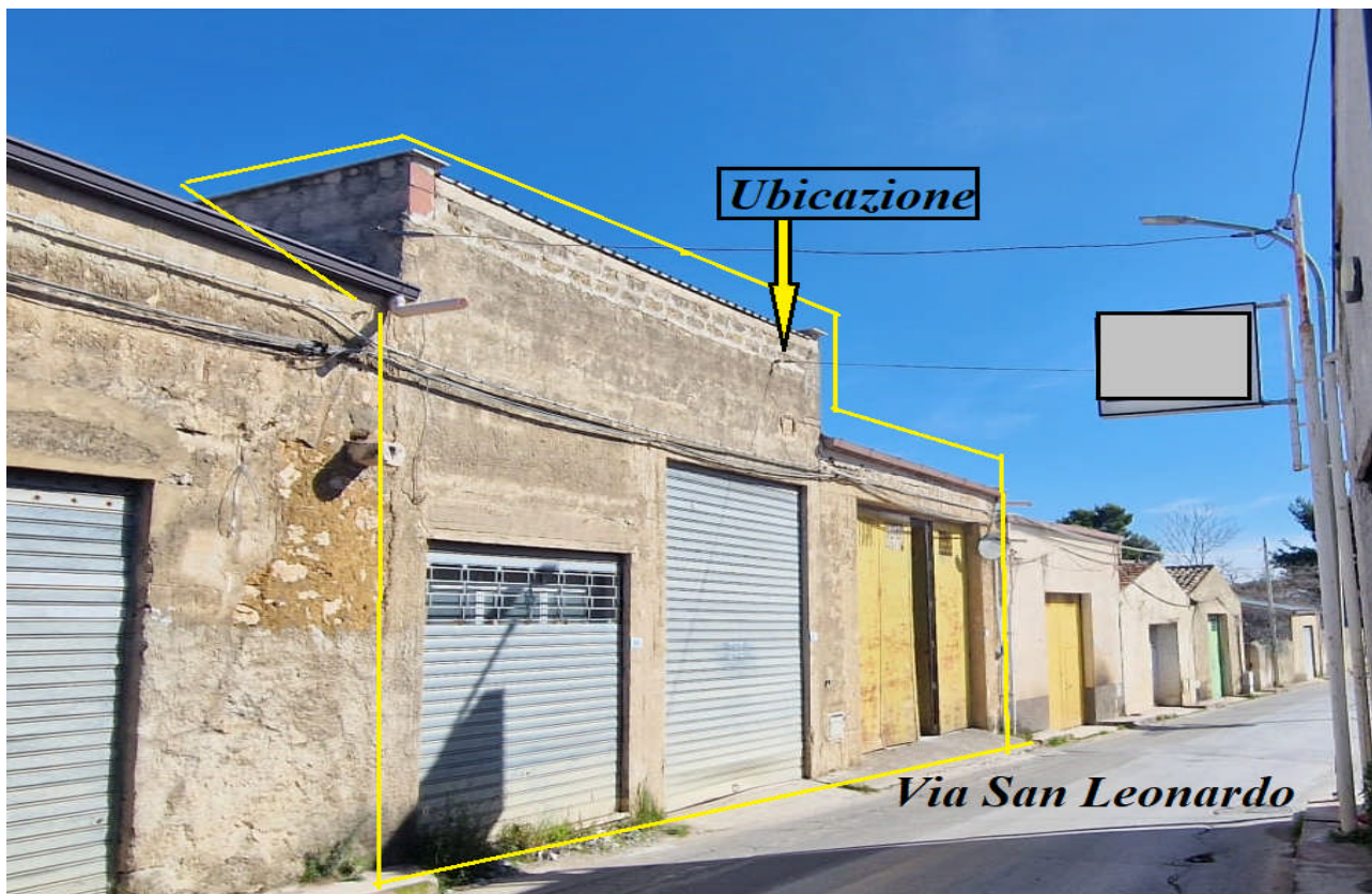
Foto 2: Panoramica esterna – locale artigianale via San Leonardo n.84-86-88, Alcamo
