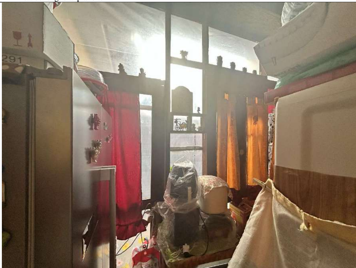
Foto n.12 – Vista dell'infisso a chiusura sulla veranda esterna
