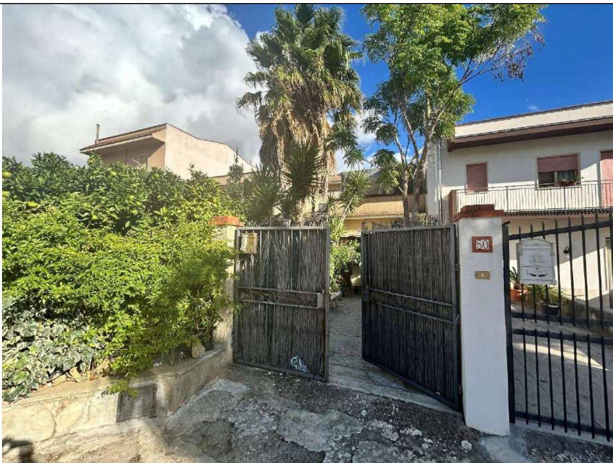
Foto n.3 – Entrata da via Aldo Moro 50. Si nota la presenza di area esterna di pertinenza al lotto.
