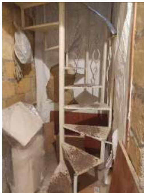
F. Particolare della scala in ferro che collega gli immobili 1. 2.
