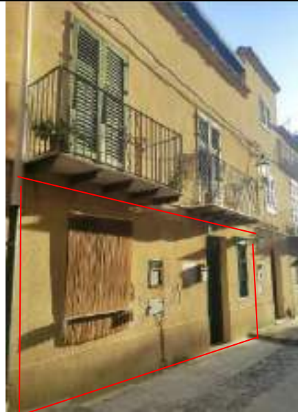
F.1 Ingresso unità immobiliare1. Via Giuseppe Garibaldi,35
