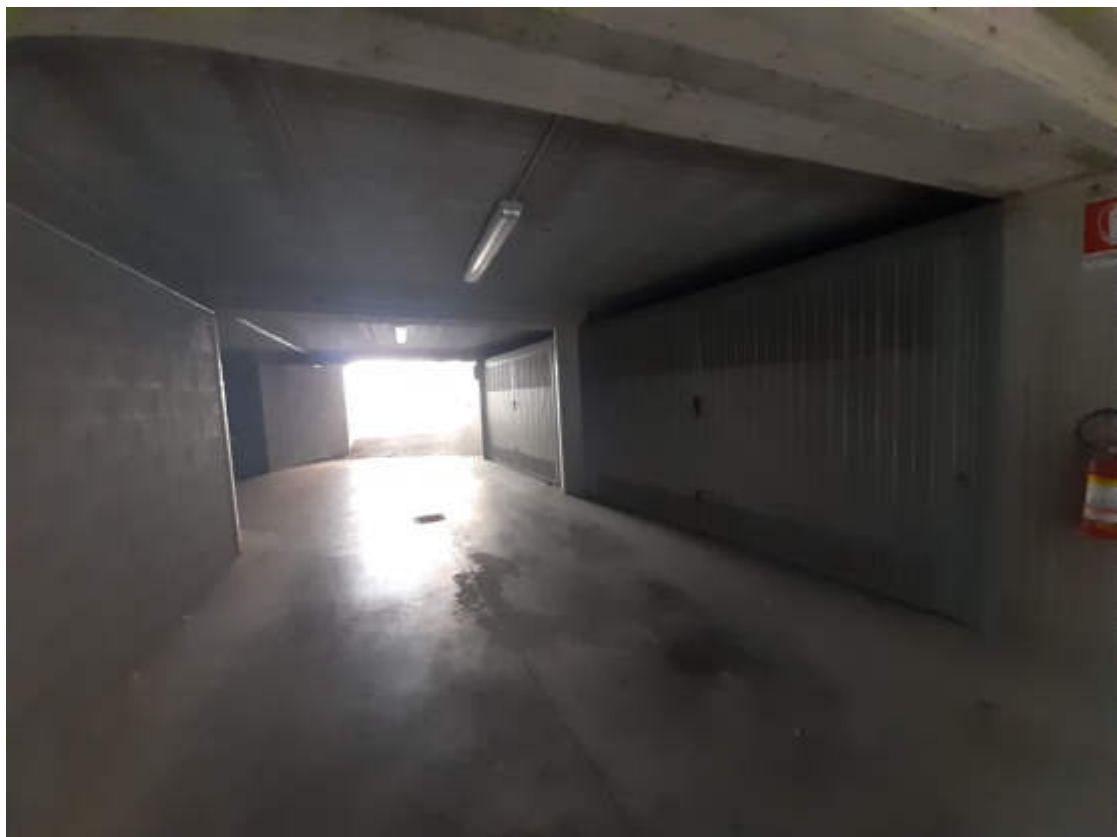
Vista interna della corsia comune di accesso al piano interrato
