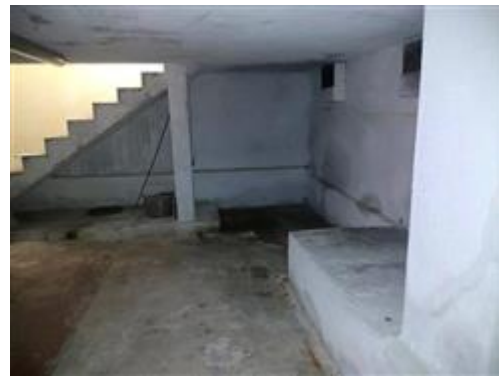
Magazzino al piano seminterrato
