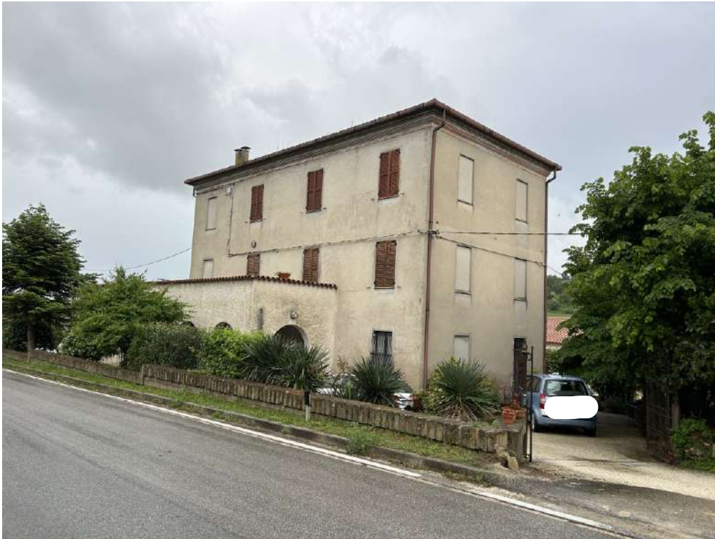
Foto n. 17 – Vista esterna fabbricato dalla strada provinciale
