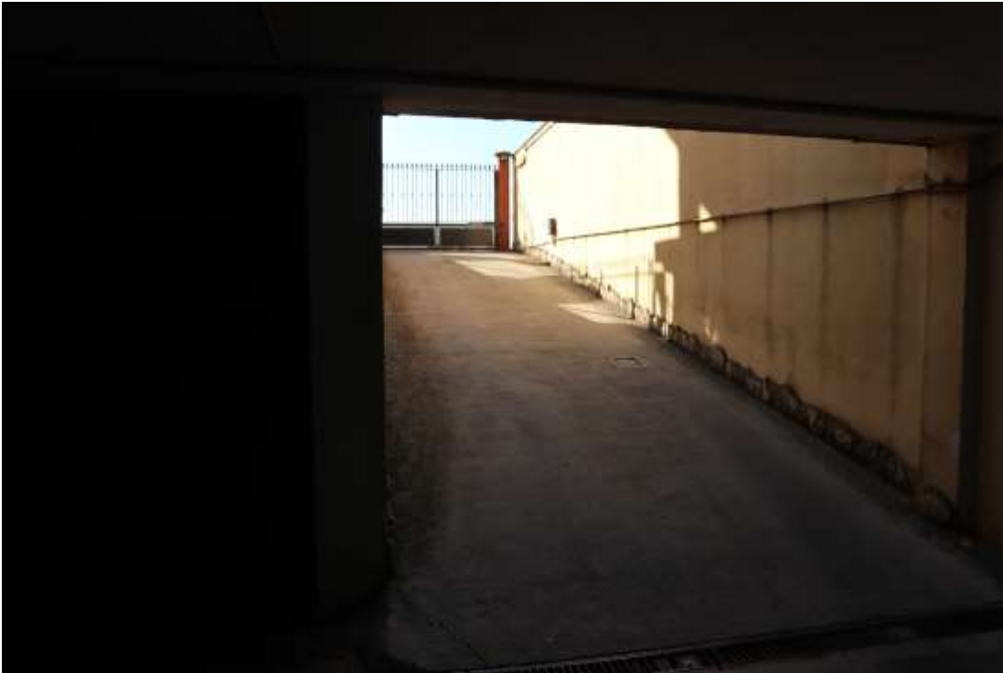
RAMPA DI ACCESSO AL GARAGE
