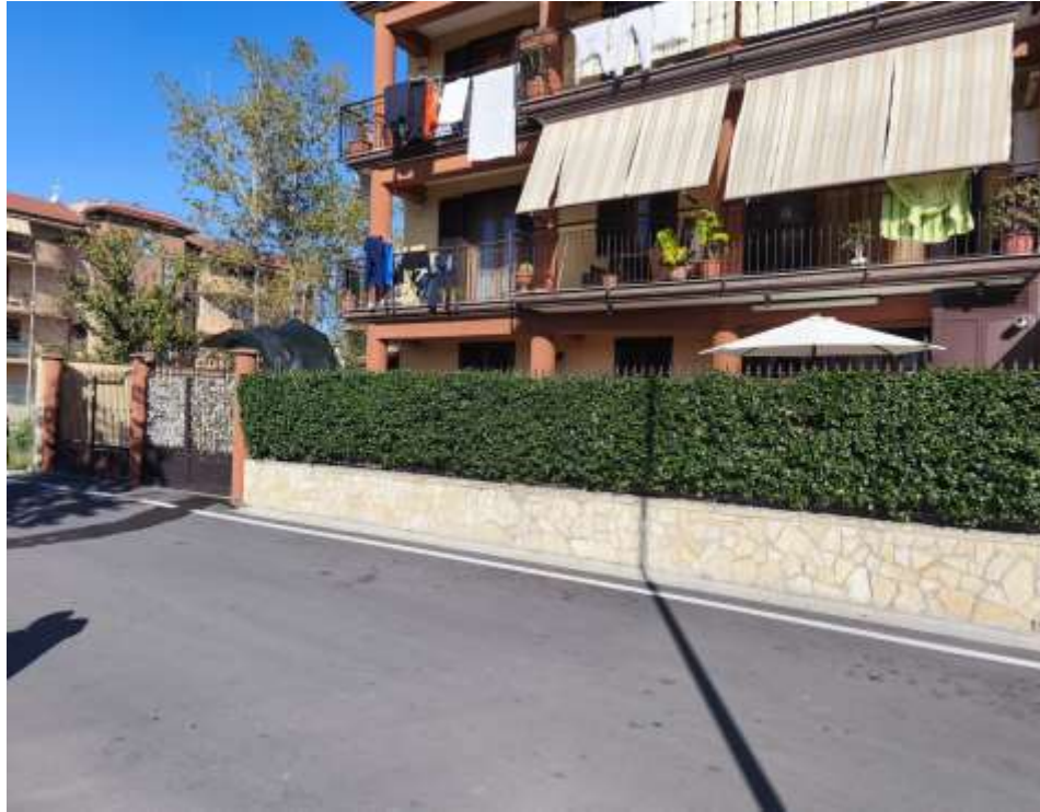
VISTA DELL'INGRESSO CARRABILE ESCLUSIVO
