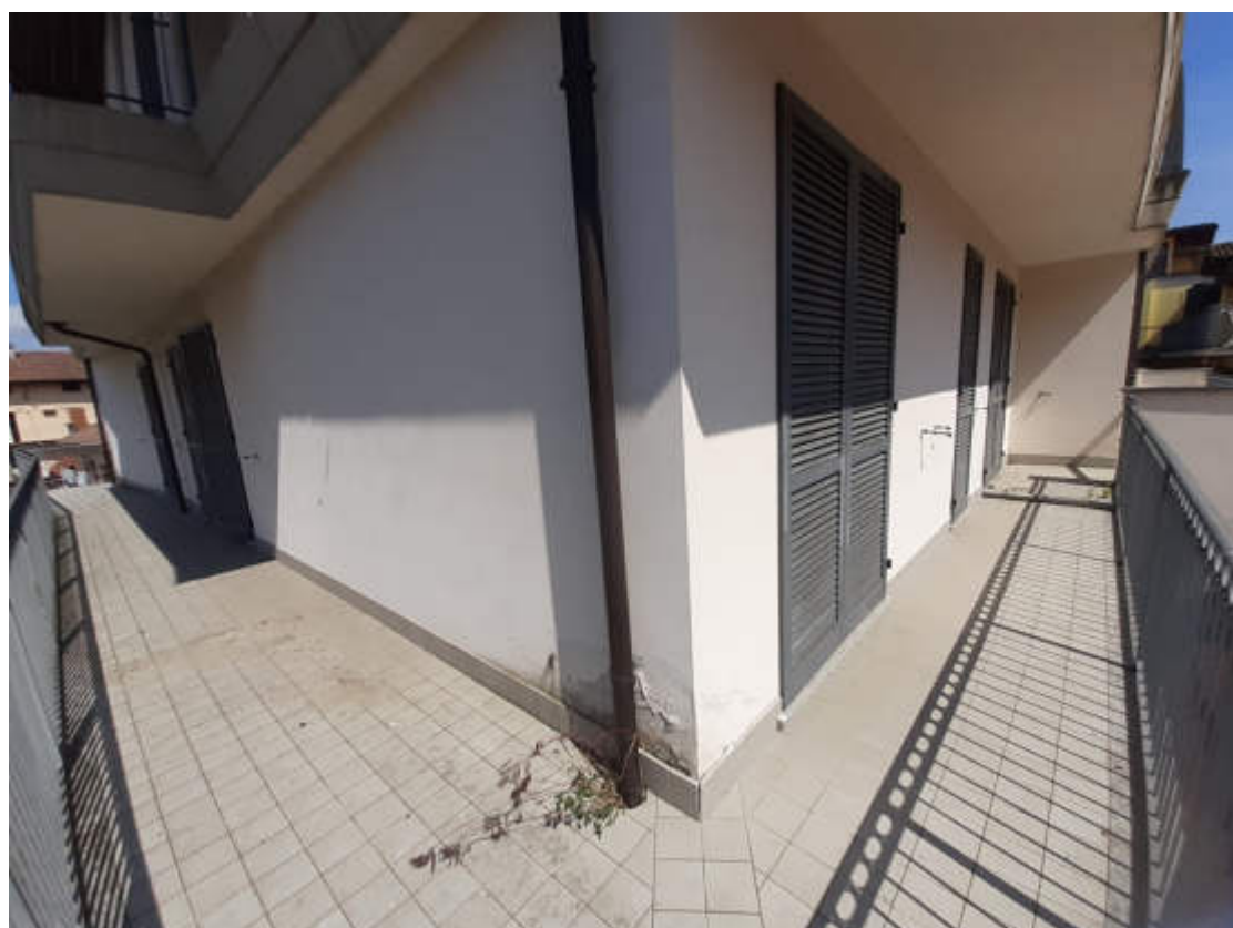
Vista esterna rifiniture terrazzi pertinentenziali posti in piano primo e secondo
