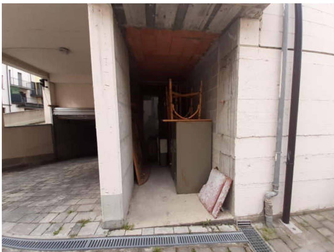
Vista dal cortile interno comune dell' accesso all'androne comune scala " E
