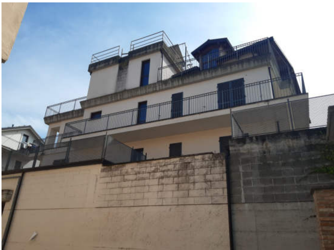
Vista dal cortile comune esterno del corpo di fabbrica oggetto di valutazione
