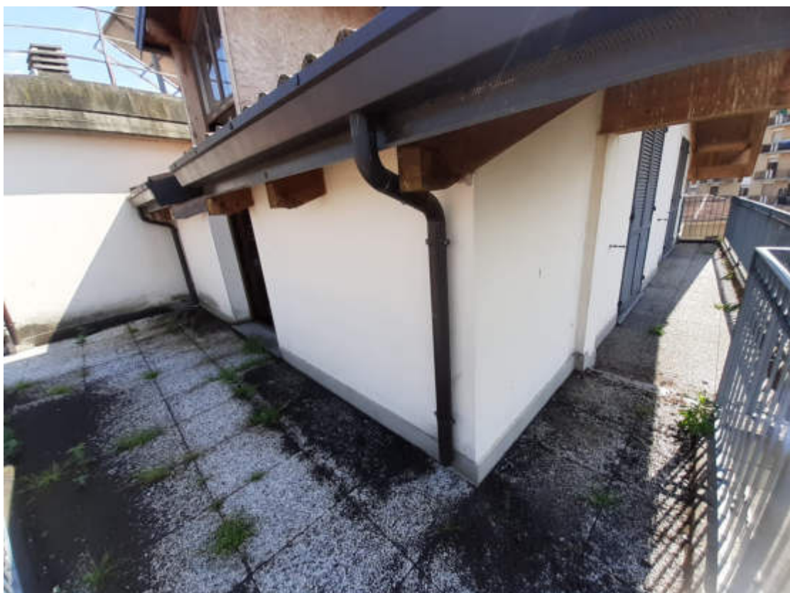
Vista esterna rifiniture terrazzi pertinentenziali posti in piano sottotetto
