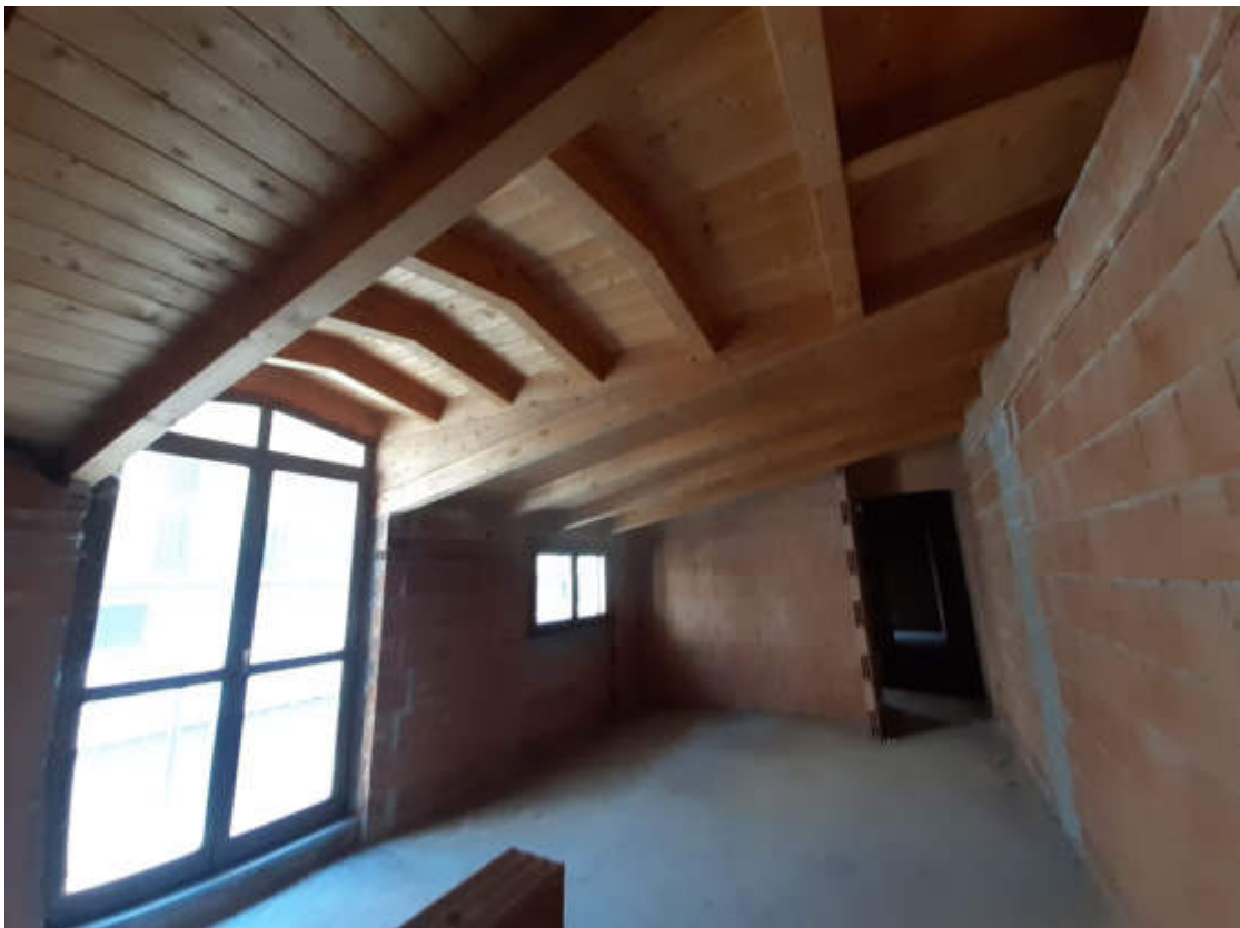
Vista interna della suddivisione degli ambienti e grado rifiniture locali in piano piano primo
