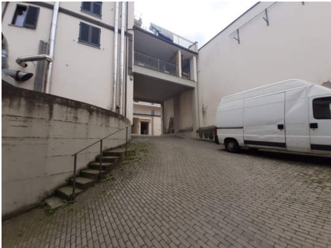
Vista dalla rampa carraia di accesso al piano seminterrato
