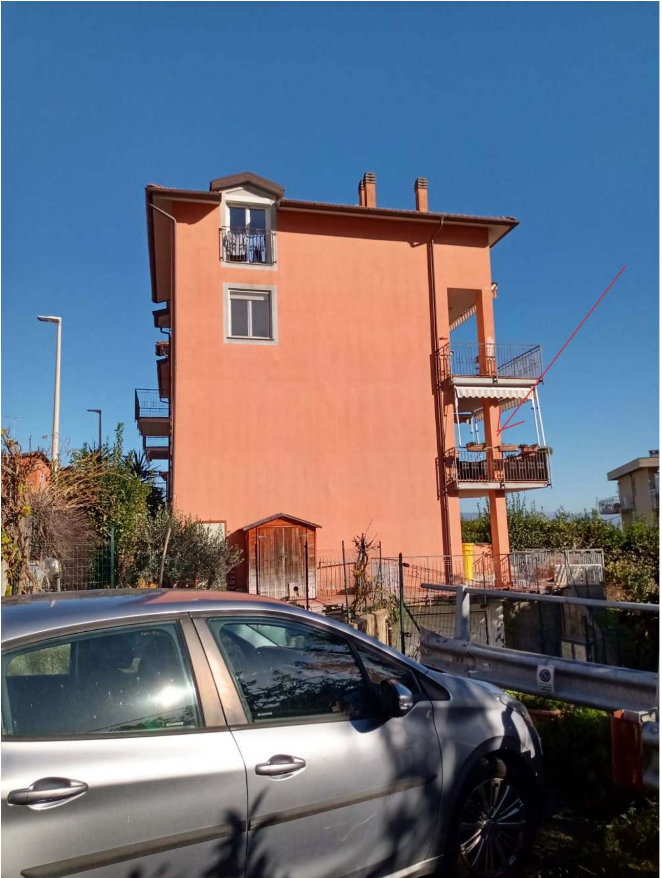
Foto n. 5 – vista lato ingresso piano seminterrato
