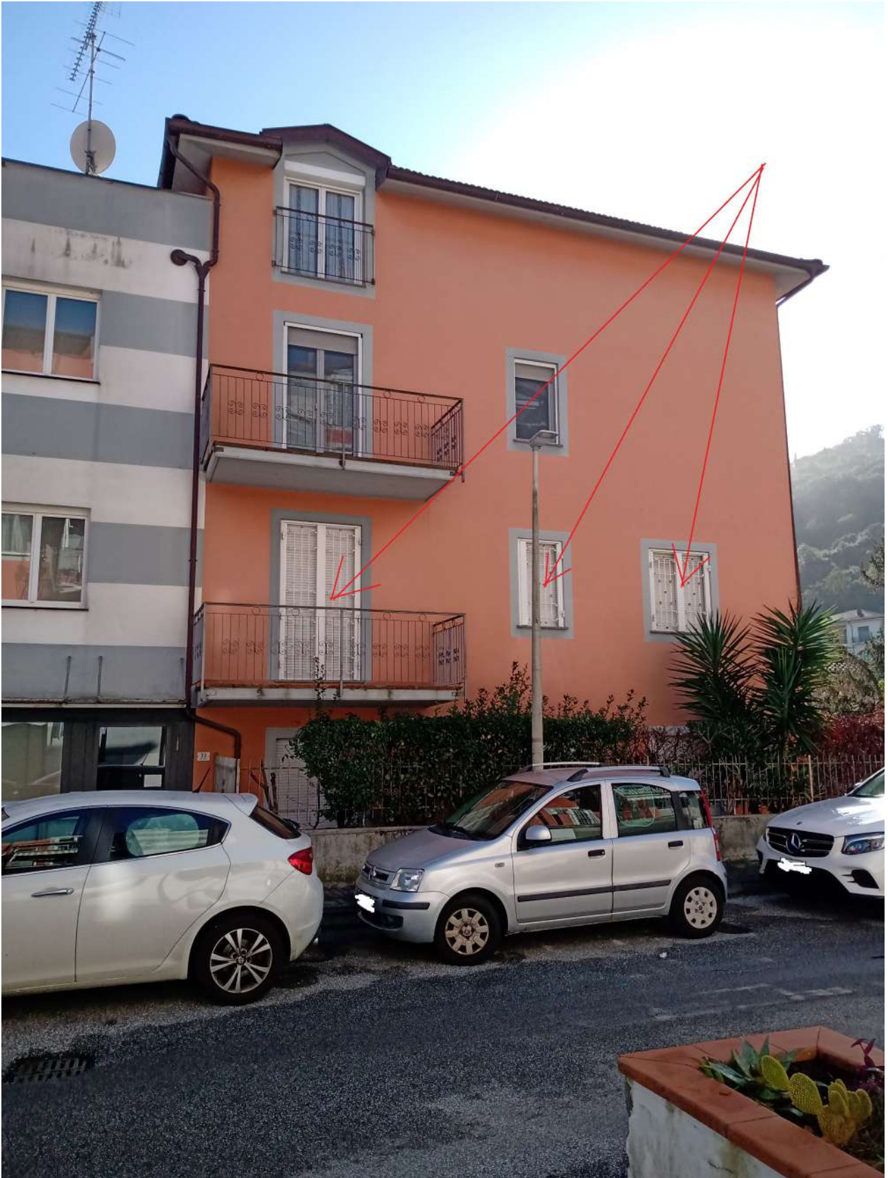
Foto n. 4 – vista lato ingresso fabbricato
