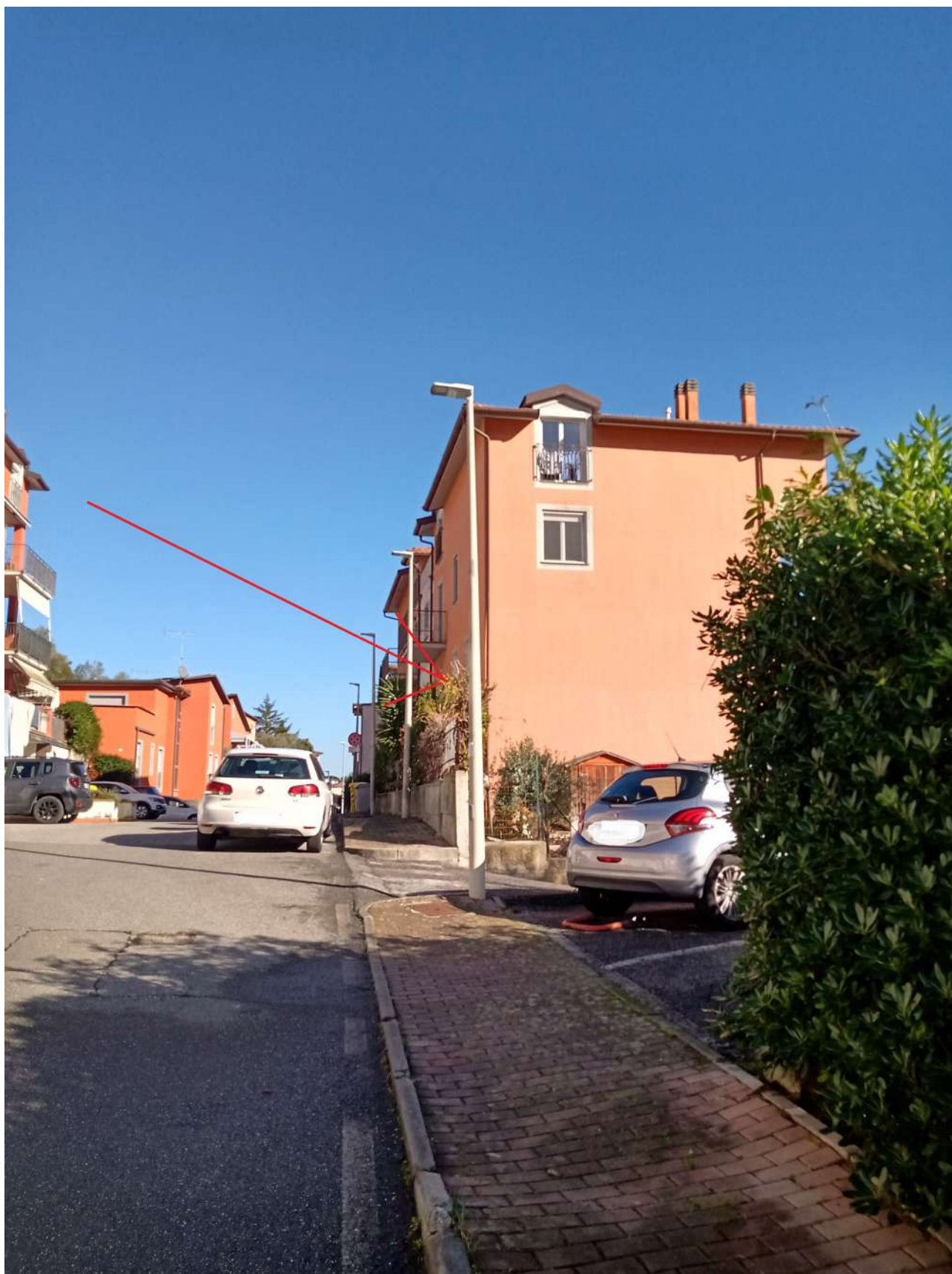
Foto n. 1 – Vista su strada di accesso al fabbricato
