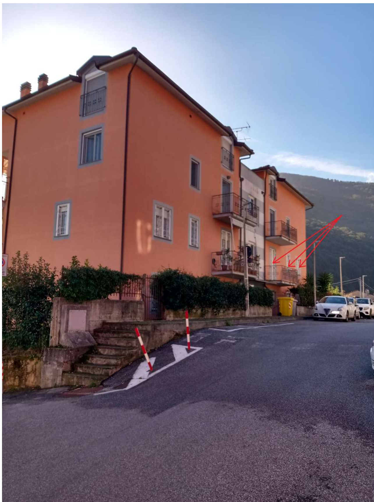
Foto n. 2 – Vista esterno fabbricato
