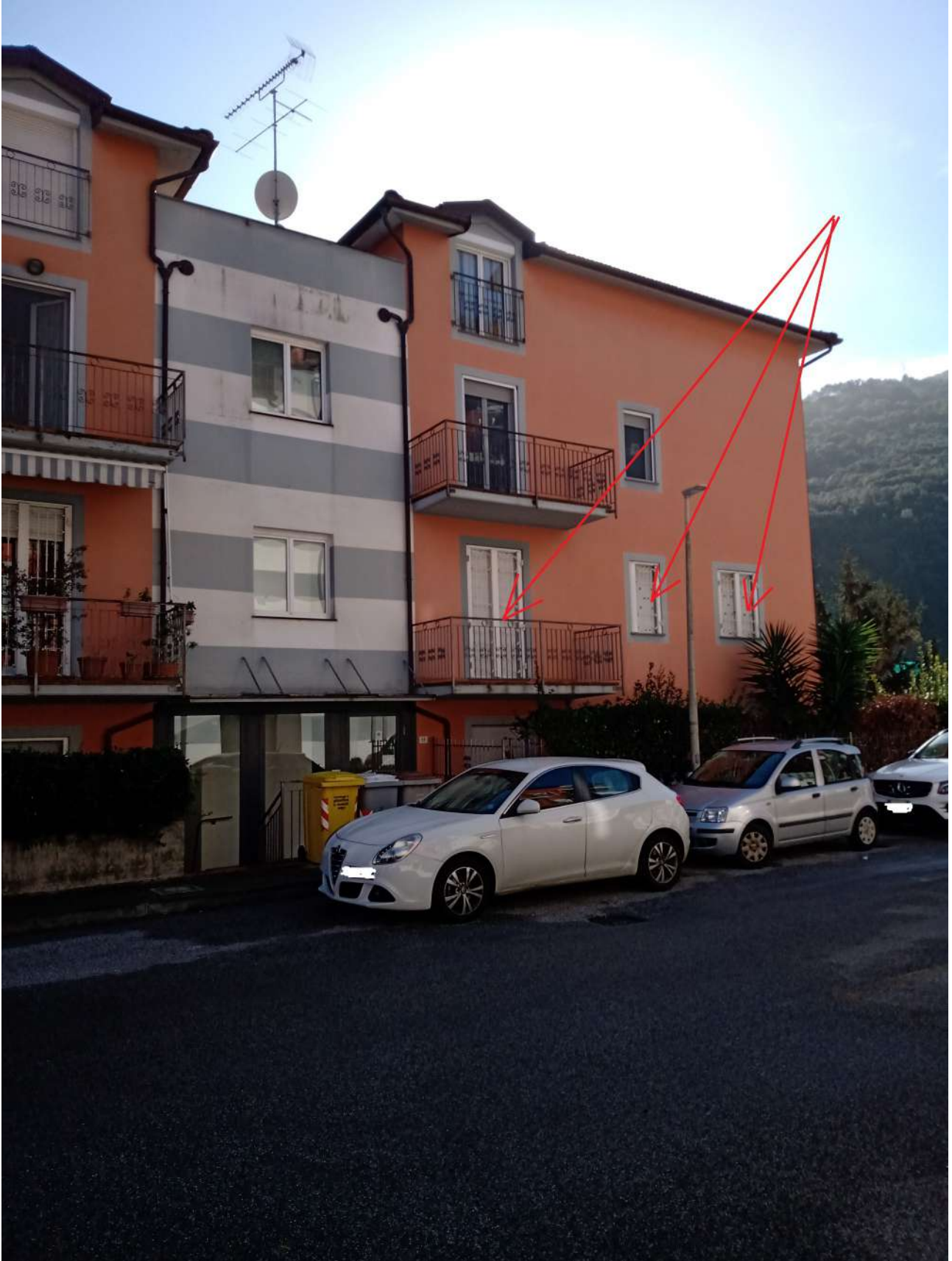
Foto n. 3 – vista lato ingresso fabbricato
