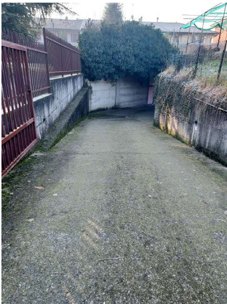
Rampa di accesso da Via Linificio
