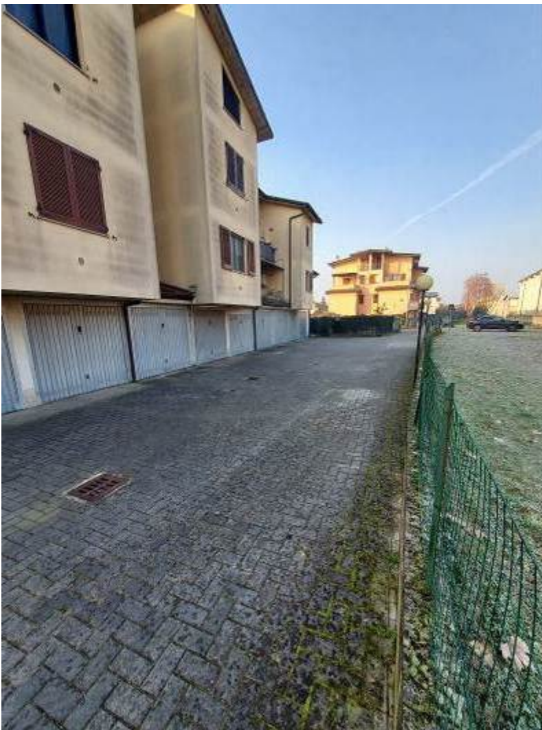
Vista dei posti auto posti lungo la recinzione
