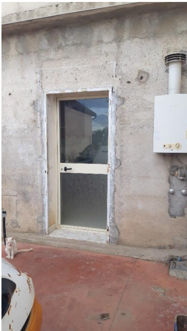
Ingresso Lato Nord – Cucina 1
