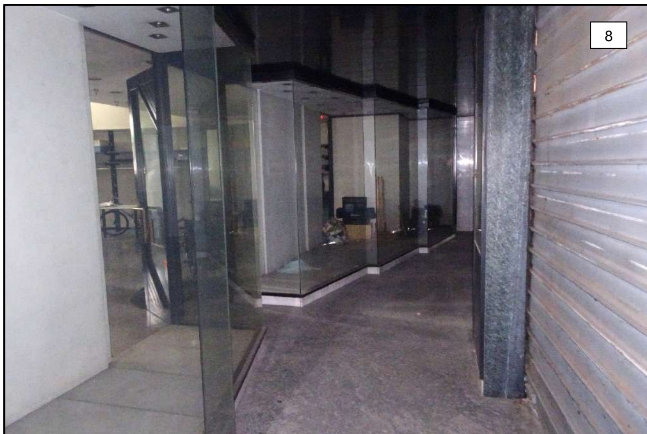
NEGOZIO – PIANO TERRA (vista interna fronte vetrine su strada)
