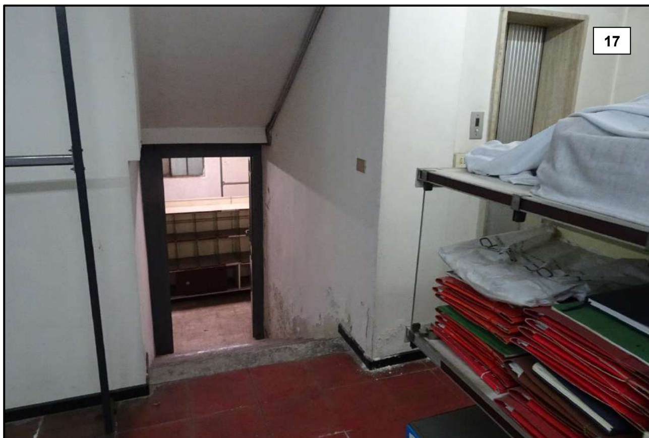
NEGOZIO - PRIMO/SECONDO PIANO INTERRATO (vista con rampa scala)
