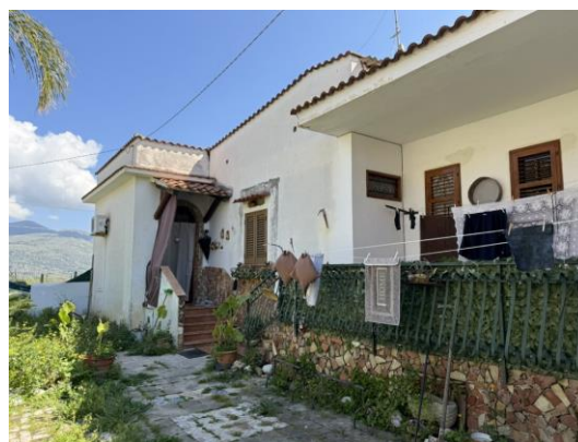
Foto n. 2. Prospetto e accesso all'immobile
