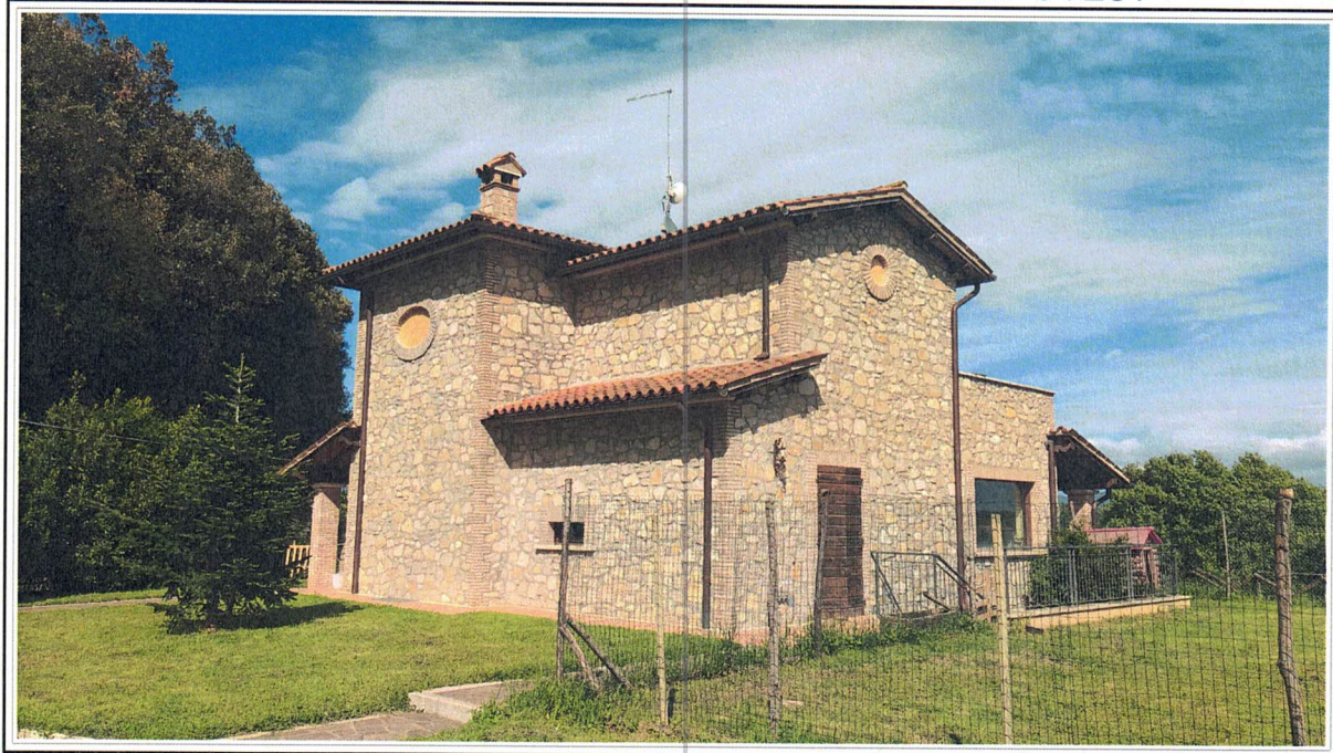
FOTO ESTERNA FABBRICATO PROSPETTO SUD-OVEST
