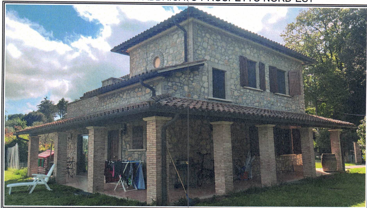
FOTO ESTERNA FABBRICATO PROSPETTO NORD-EST
