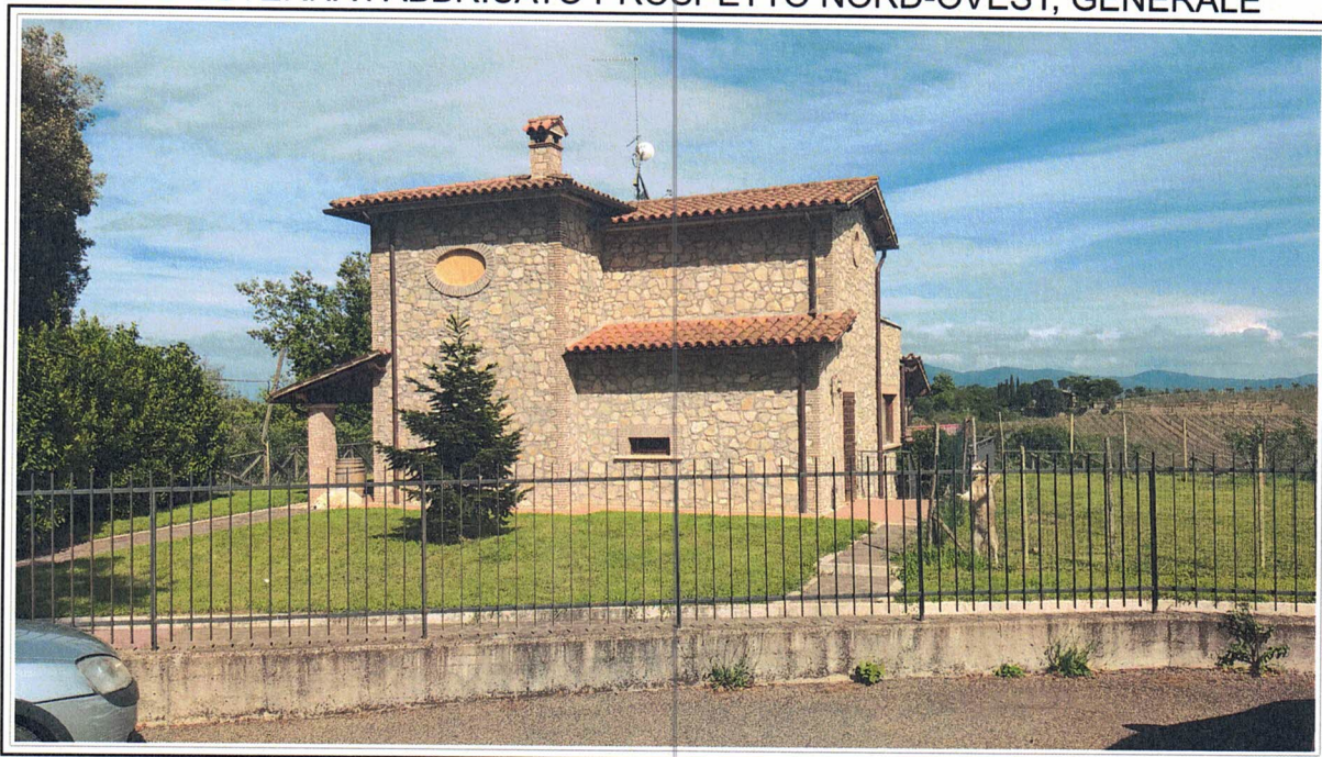
FOTO ESTERNA FABBRICATO PROSPETTO NORD-OVEST, GENERALE
