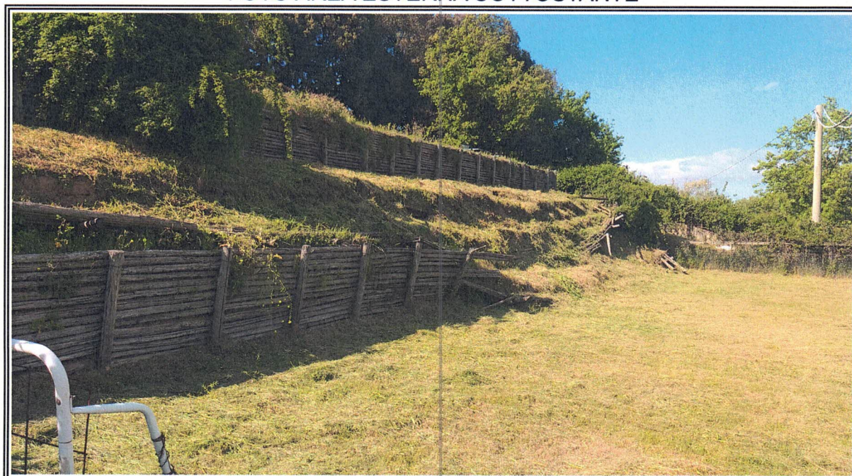
FOTO AREA ESTERNA SOTTOSTANTE
