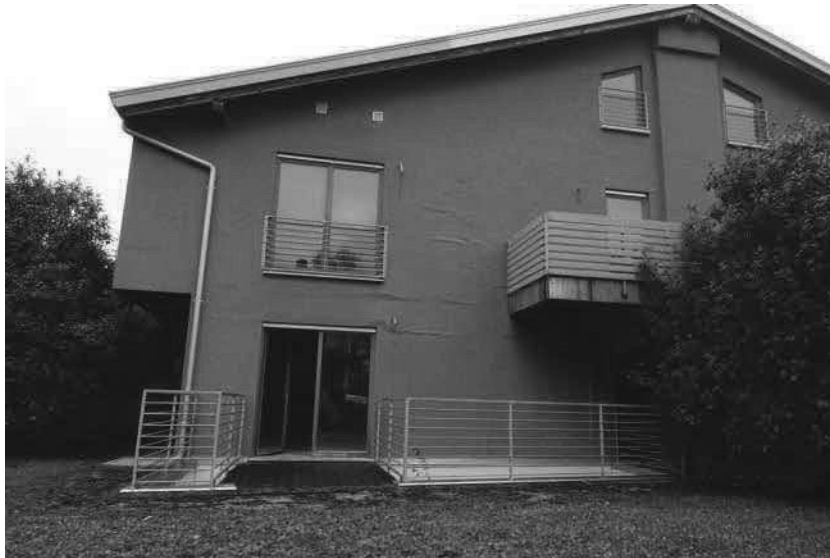
Vista fabbricato A da sud
