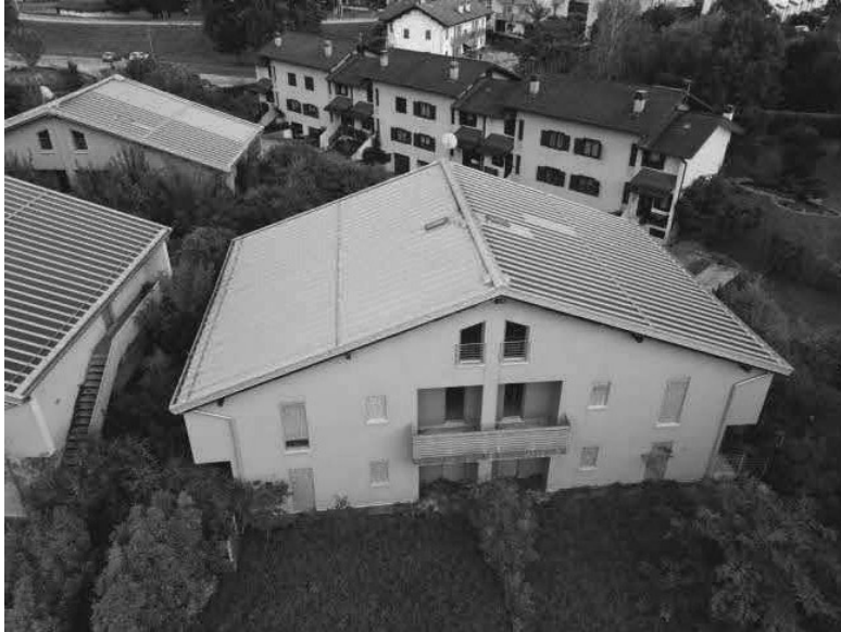
Vista fabbricato B1
