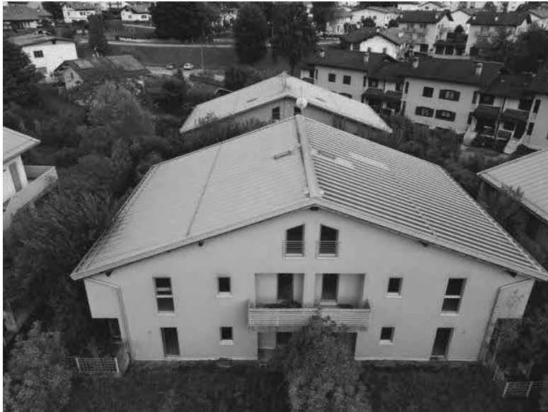
Vista fabbricato B2
