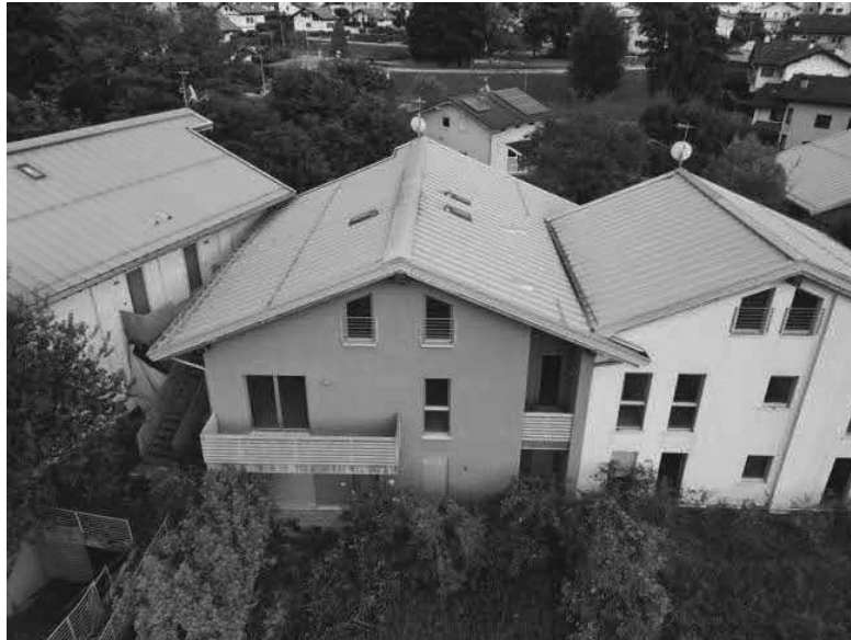
Vista fabbricati C1
