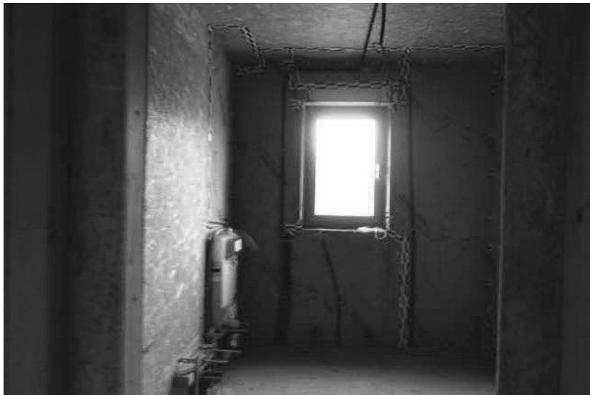
Vista bagno P.T. unità 11 fabbricato B2
