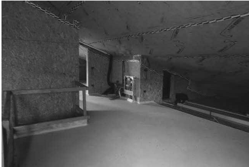
Vista sottotetto unità 11 fabbricato B2
