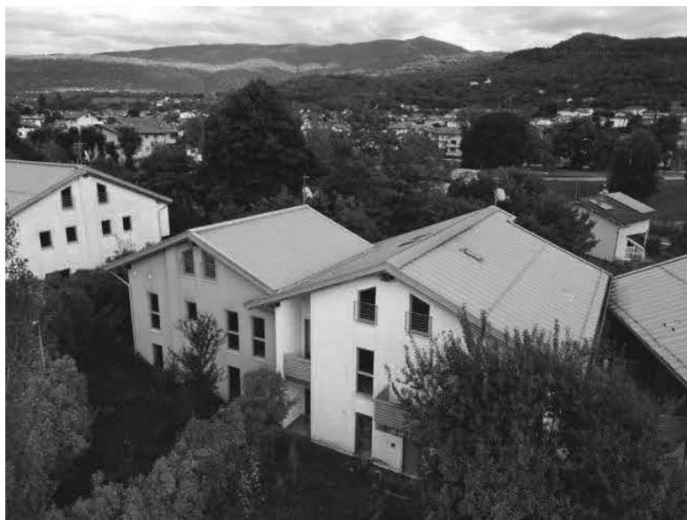
Vista fabbricati C2
