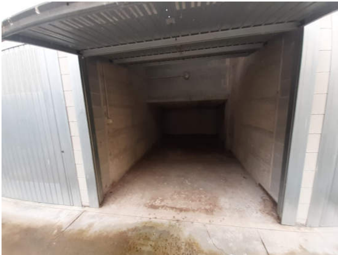
Vista interna della U.I.U. oggetto di valutazione
