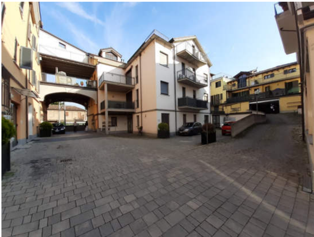
Vista dal cortile interno comune del portone carraio di accesso al piano terra rialzato
