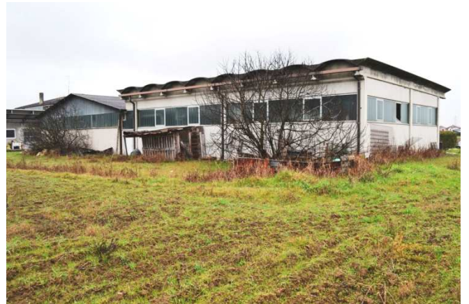
foto 6 - Prospetto sud ovest (retro) del laboratorio
