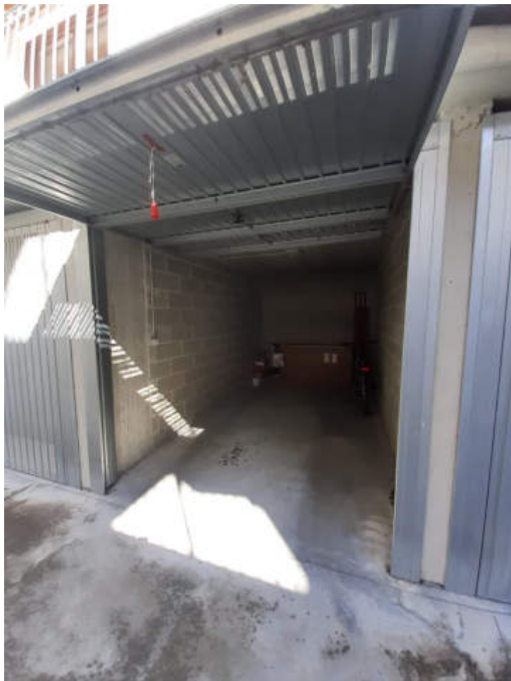
Vista interna della U.I.U. oggetto di valutazione
