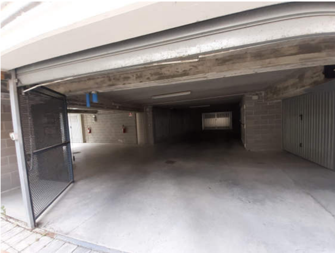
Vista della corsia comune di accesso al piano terra rialzato
