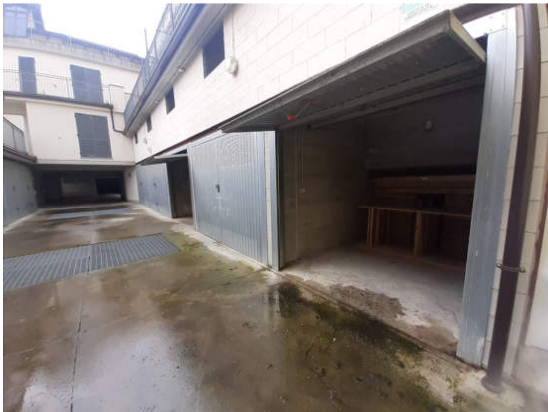
Vista da corsia di accesso comune del portone di accesso alla U.I.U. oggetto di valutazione
