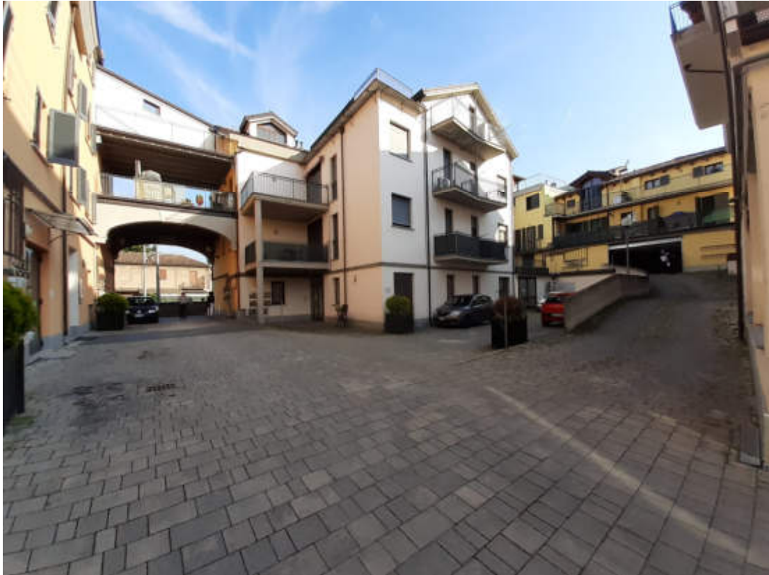
Vista dal cortile interno comune del portone carraio di accesso al piano terra rialzato
