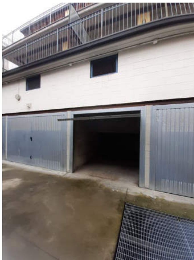
Vista da corsia di accesso comune del portone di accesso alla U.I.U. oggetto di valutazione
