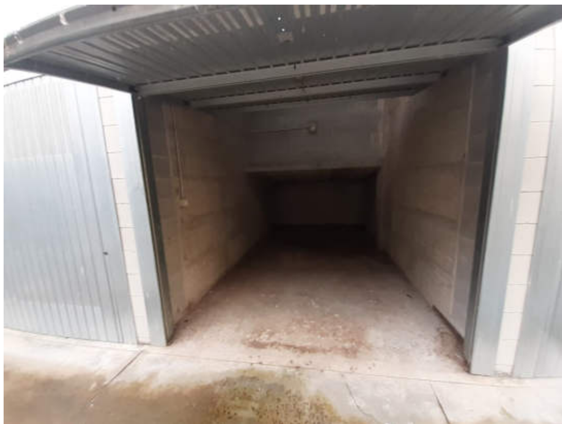
Vista interna della U.I.U. oggetto di valutazione
