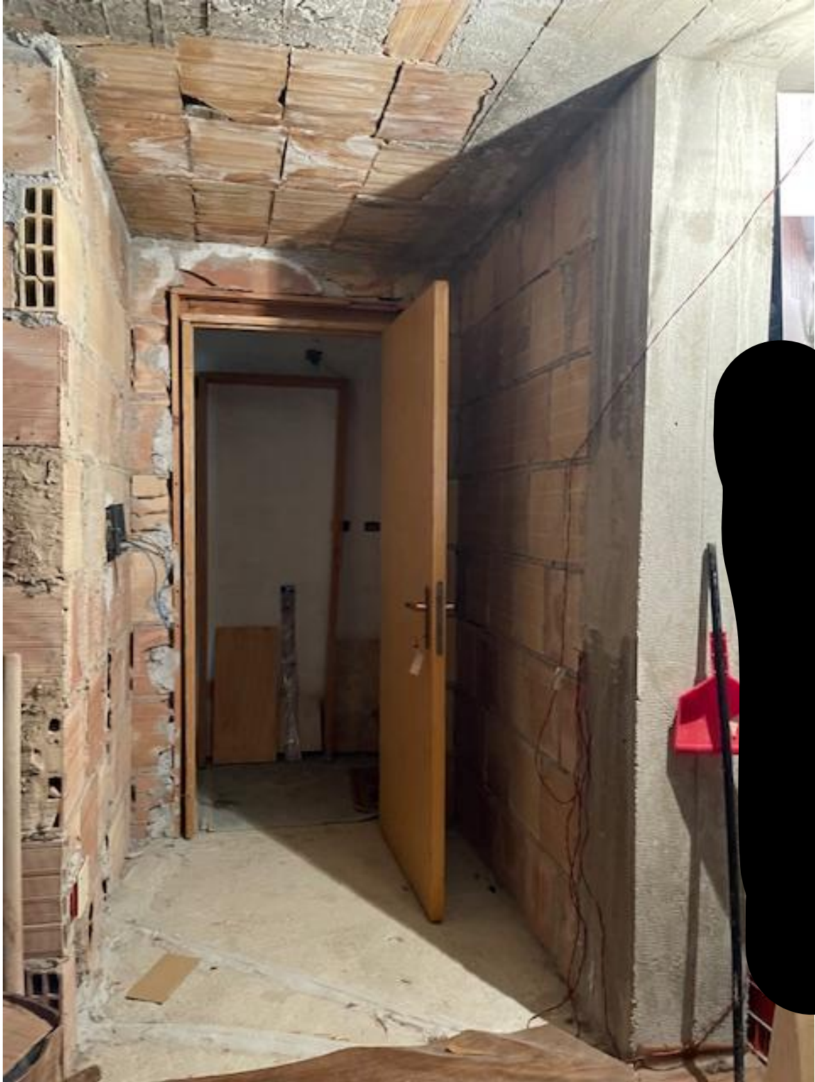
vista dell'ingresso al locale sottotetto
