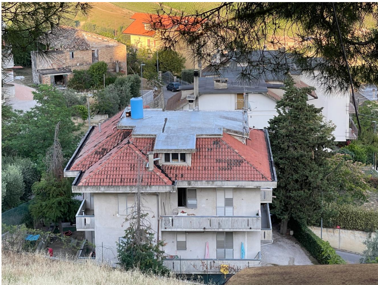
vista della copertura e del prospetto ovest
