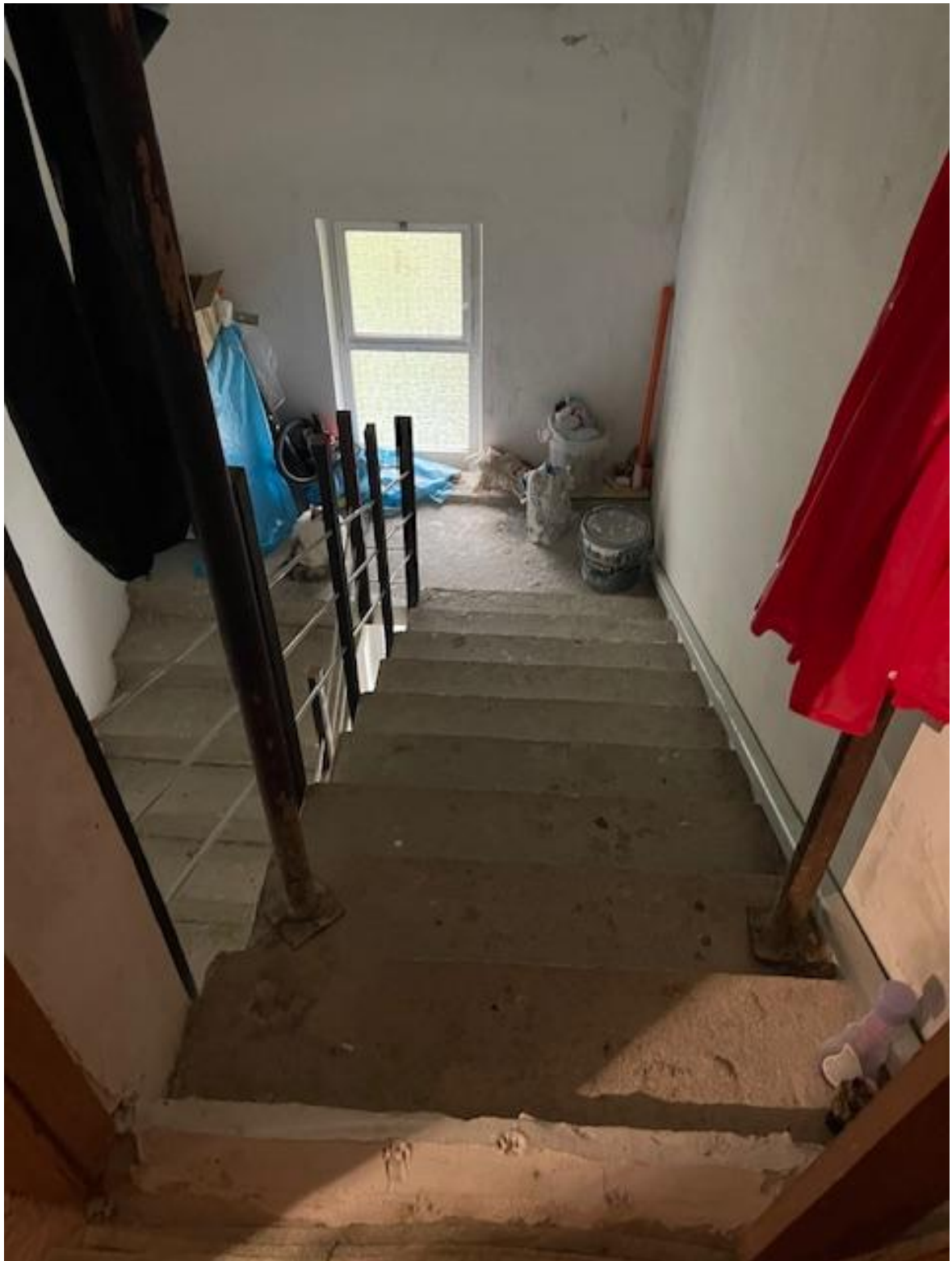
vista della scala interna di distribuzione ai vari piani lasciata al grezzo
