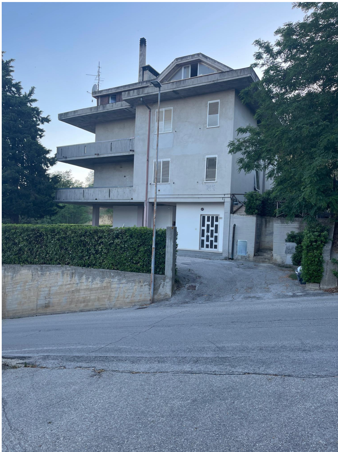
vista del fabbricato da Via Fonte Vecchia – accesso alla corte (lato est)
