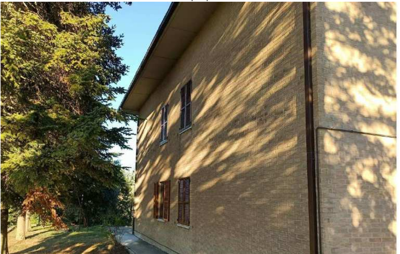
Foto prospetto nord
