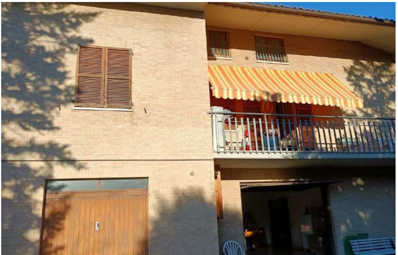
Foto prospetto ovest
