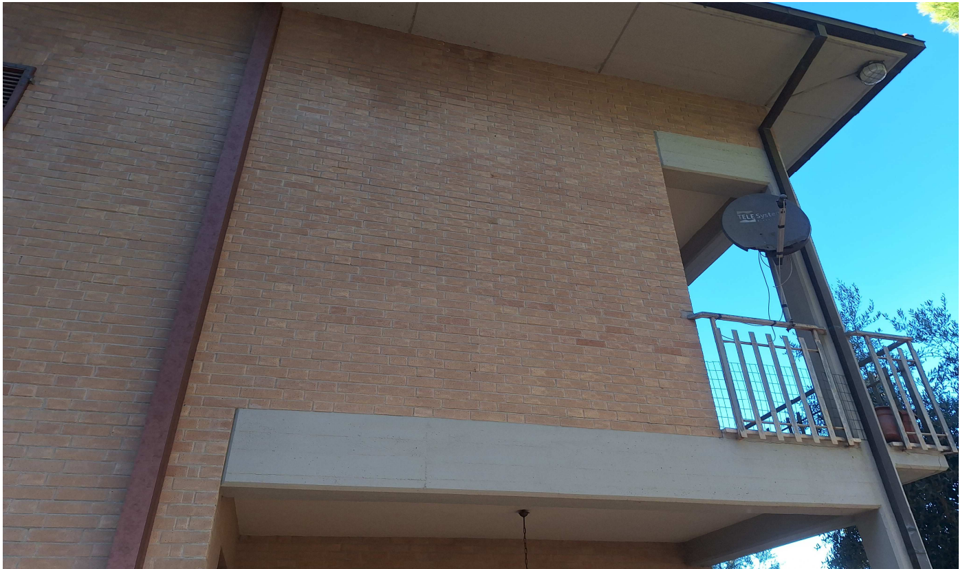
Foto prospetto sud
