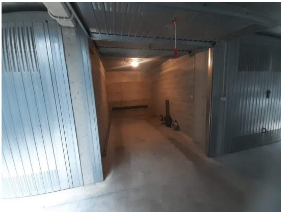
Vista interna della U.I.U. oggetto di valutazione
