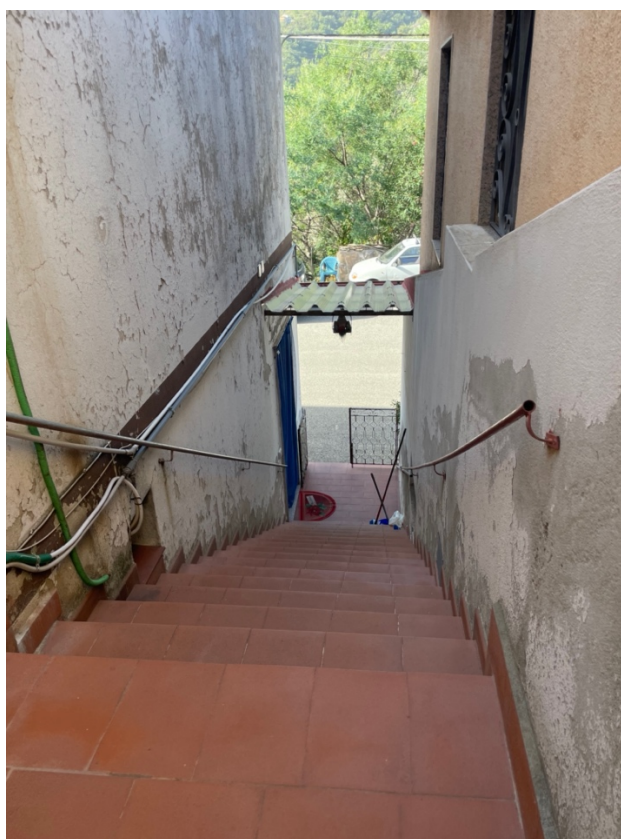
Vista scala esterna da pianerottolo ingresso abitazione
