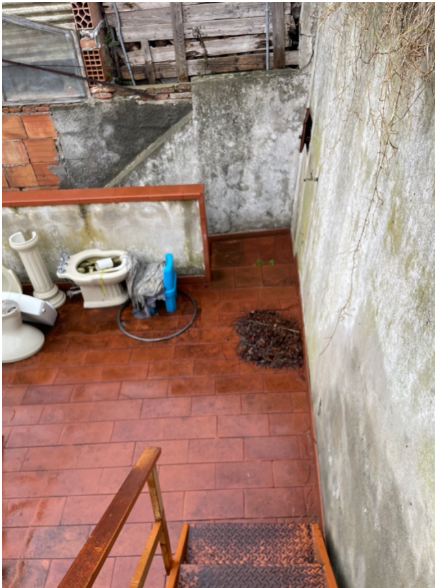
Terrazza con deposito sub 4 e scala amovibile in ferro
