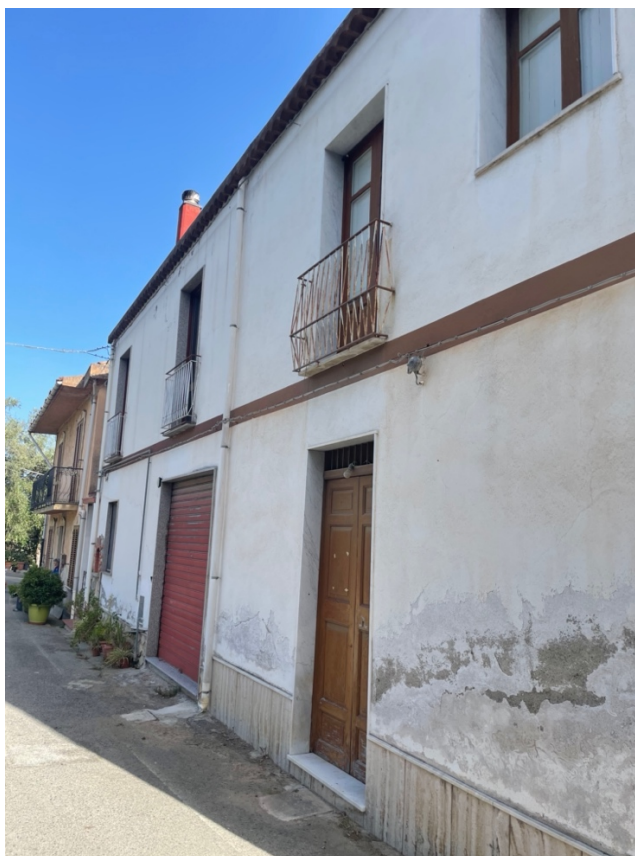
Altra vista su prospetto principale
