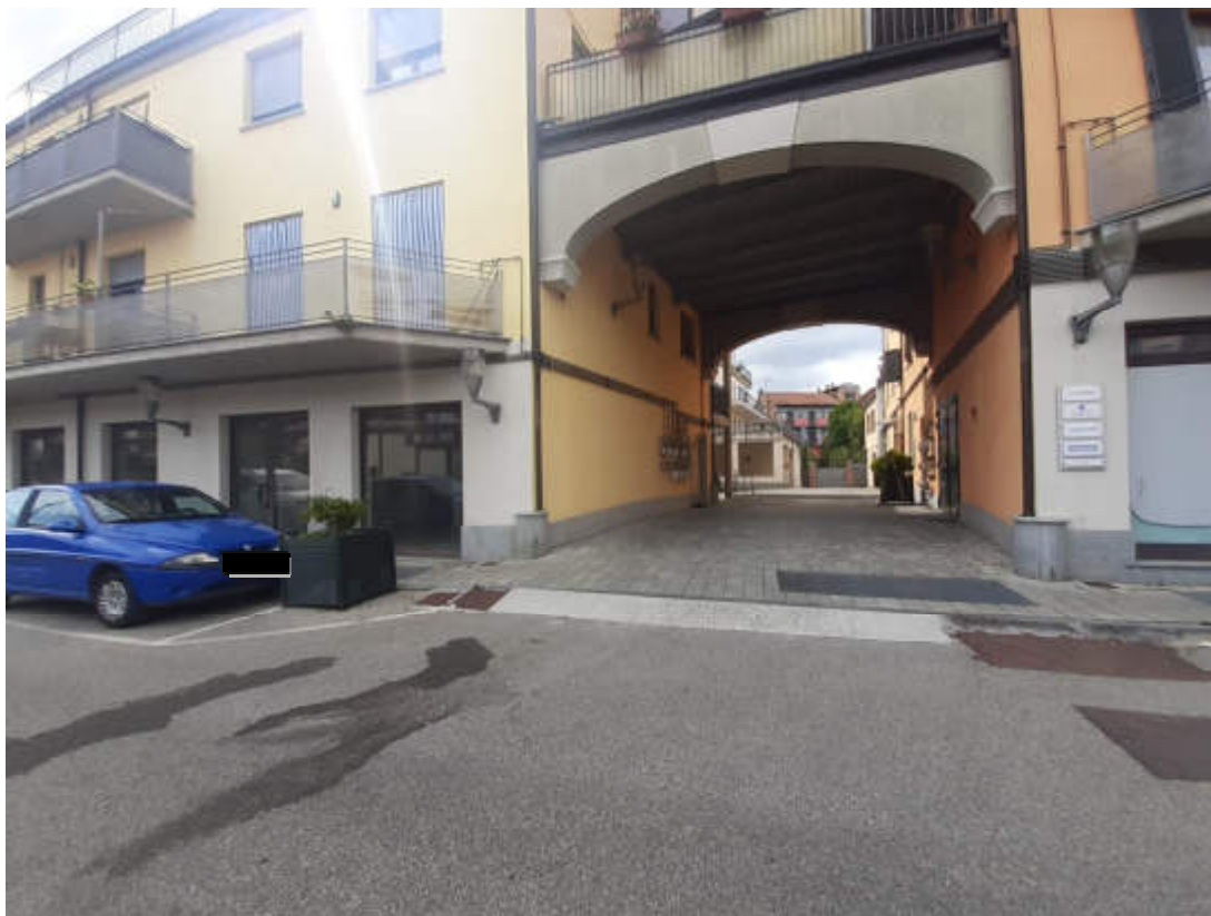
Vista dalla sede stradale di Via San Carlo dell'androne carraio di accesso al compendio Immobiliare
