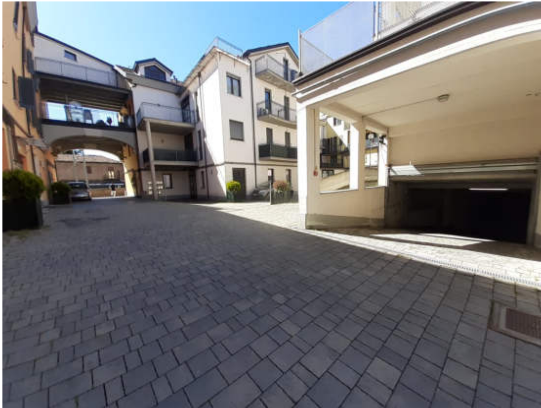
Vista dal cortile interno comune del portone carraio di accesso al piano seminterrato
