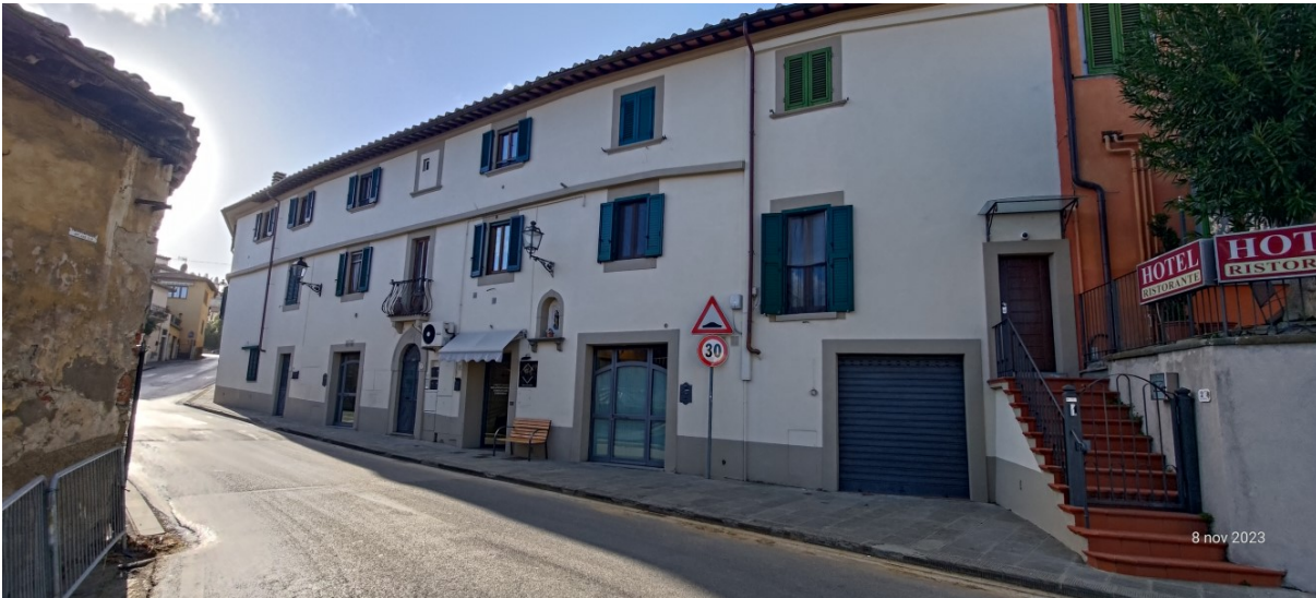
Figura 3 – Particolare immobile da via Jacopo Modesti
