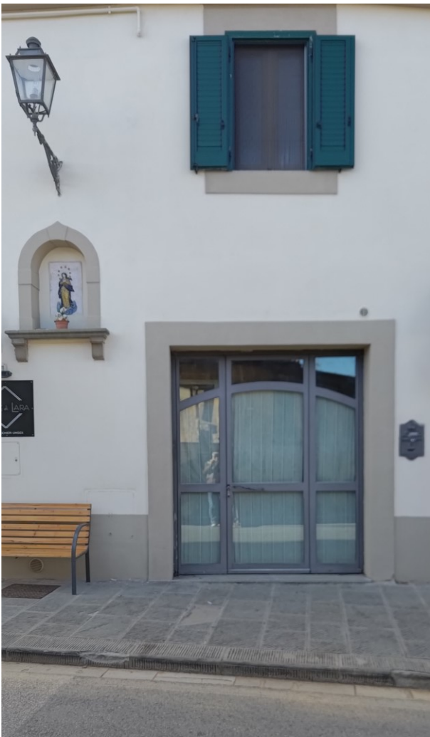
Foto 2 – fronte edificio – accesso fondo via Jacopo Modesti n. 6
