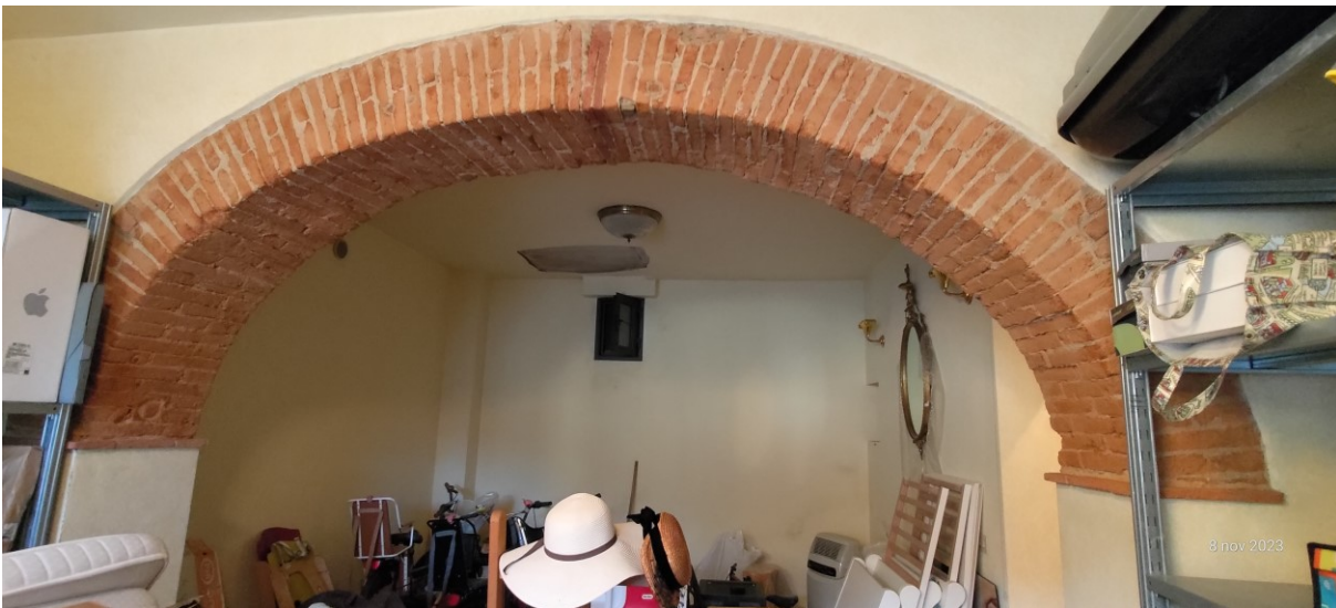
Foto 6 – particolare fondo da ingresso
