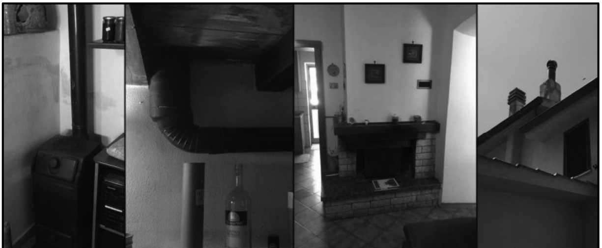
Stufa a legna e camino a legna e canne fumarie in copertura
