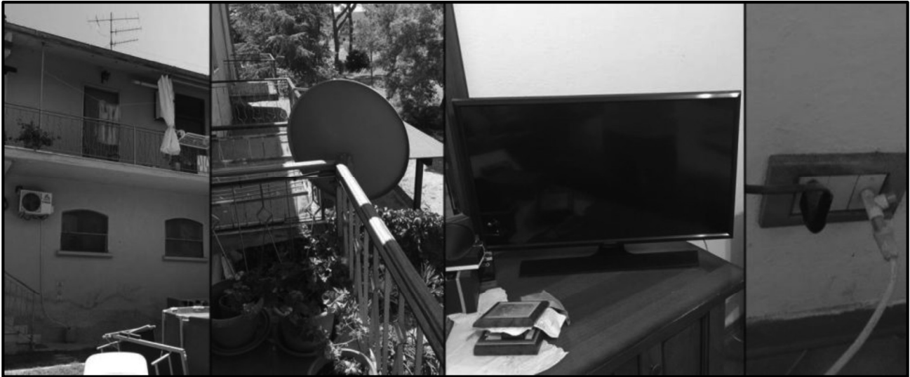
Antenna condominiale, parabole, apparecchio tv e presa antenna
