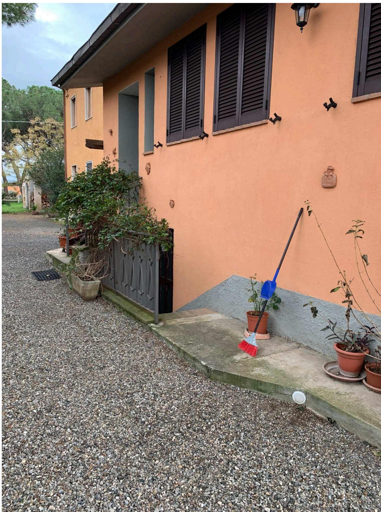
PODERE TERNOVA – VISTA ACCESSO LOCALE PIANO SEMINTERRATO
