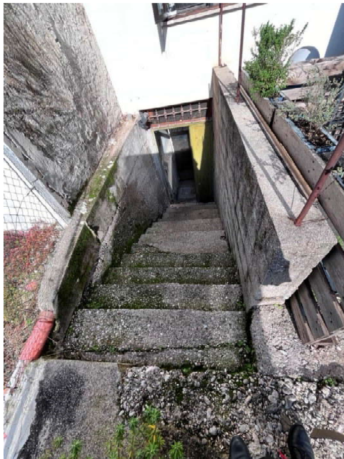
accesso alla cantina interrata dal cortile
