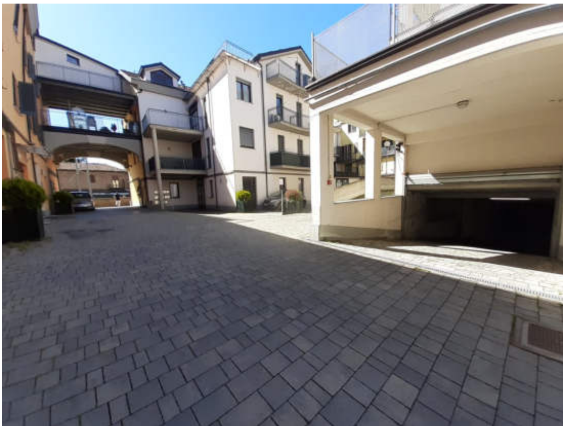
Vista dal cortile interno comune del portone carraio di accesso al piano seminterrato
