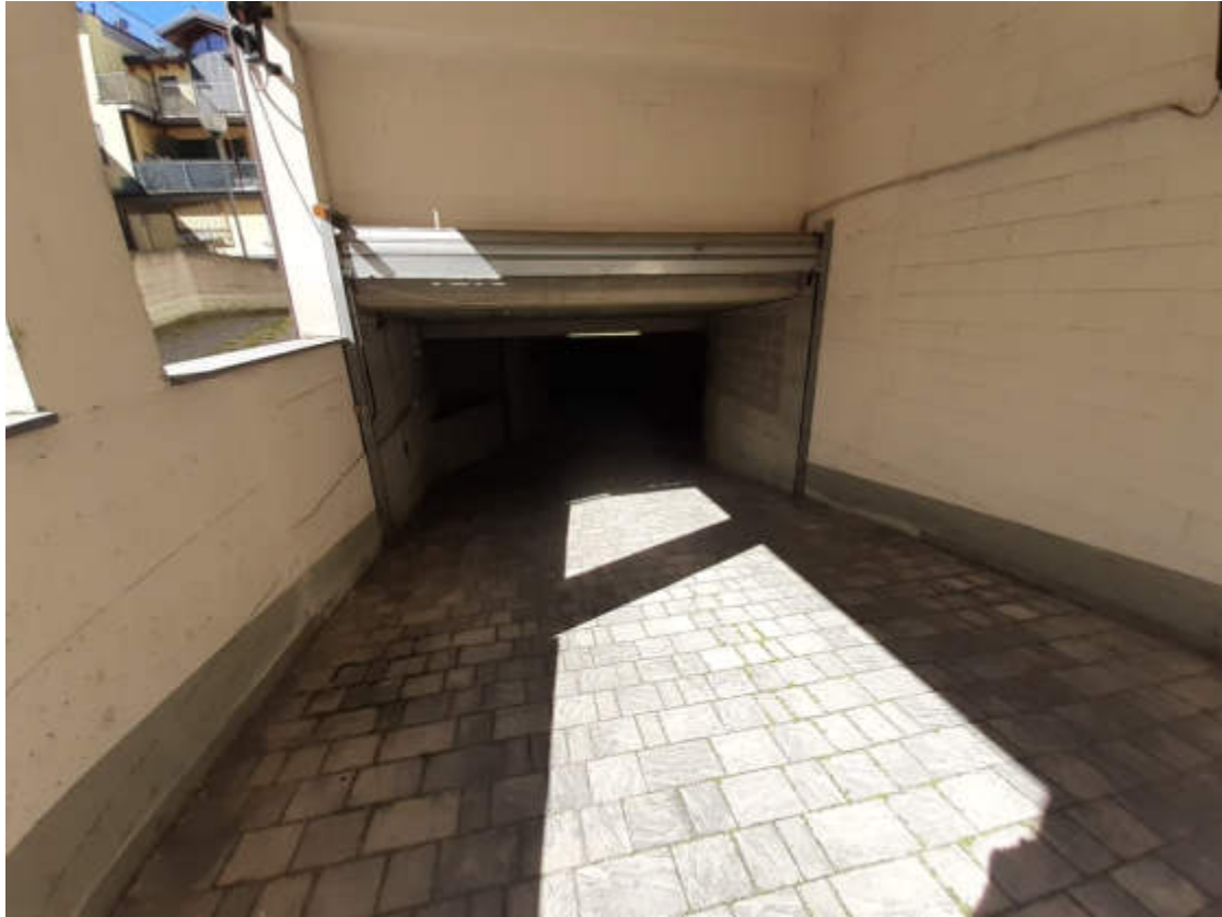
Vista della corsia comune di accesso al piano seminterrato
