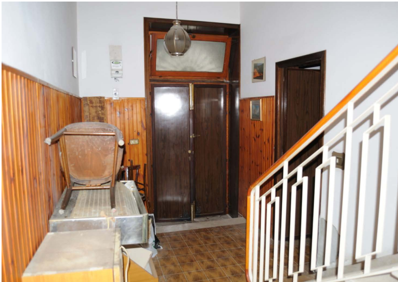
FOTO 5 – Ingresso piano terra
