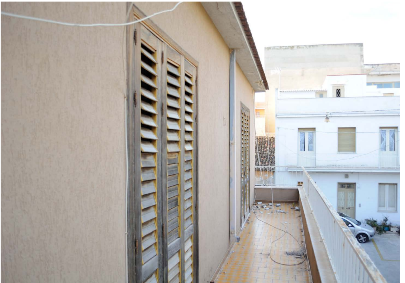
FOTO 4 – Terrazza piano primo
