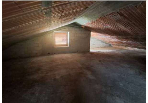
26. Vista sottotetto verso l'ingresso.
