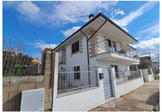
2. Vista Nord-Ovest da via Milano.
