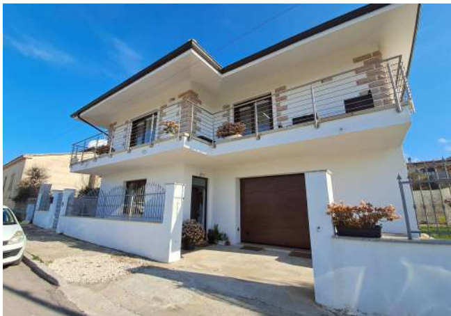
3. Vista Sud-Ovest da via Milano _accesso al garage.
