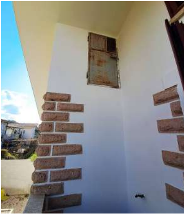
25. Accesso al sottotetto e tetto dalla veranda posteriore.
