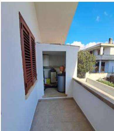
23. Veranda posteriore con vano tecnico.
