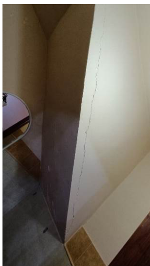
Lesione soletta scala Lesione struttura verticale
