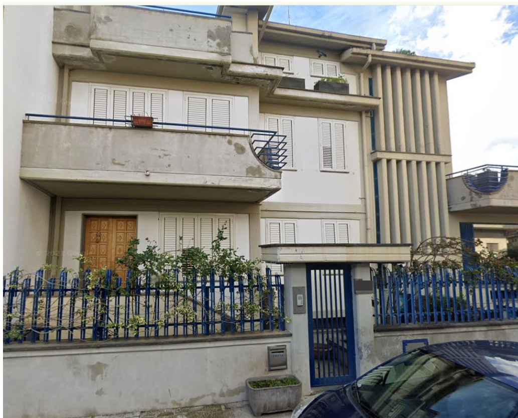
Vista frontale dell'immobile
