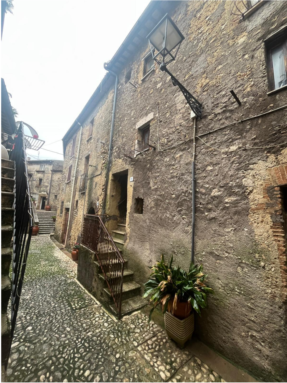
Foto n. 1 – Prospetto del fabbricato
