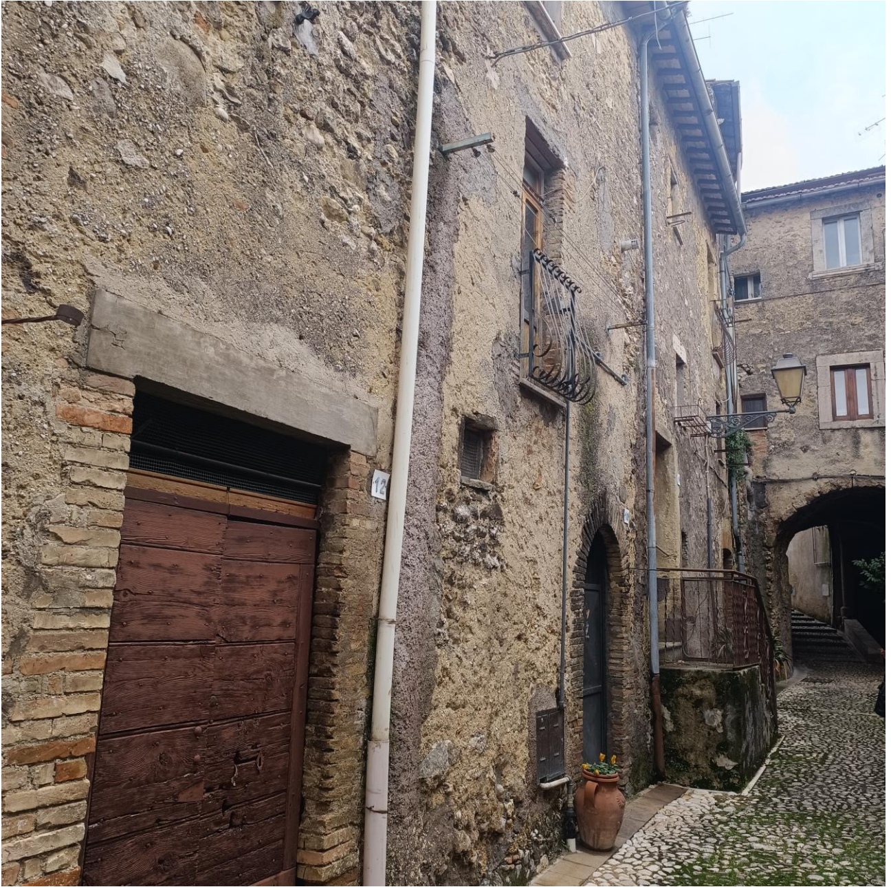
Foto n. 2 – Prospetto del fabbricato
