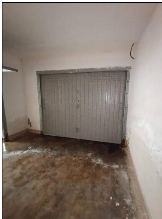
FOTO 6: Garage sub. 18, con apertura basculante.
