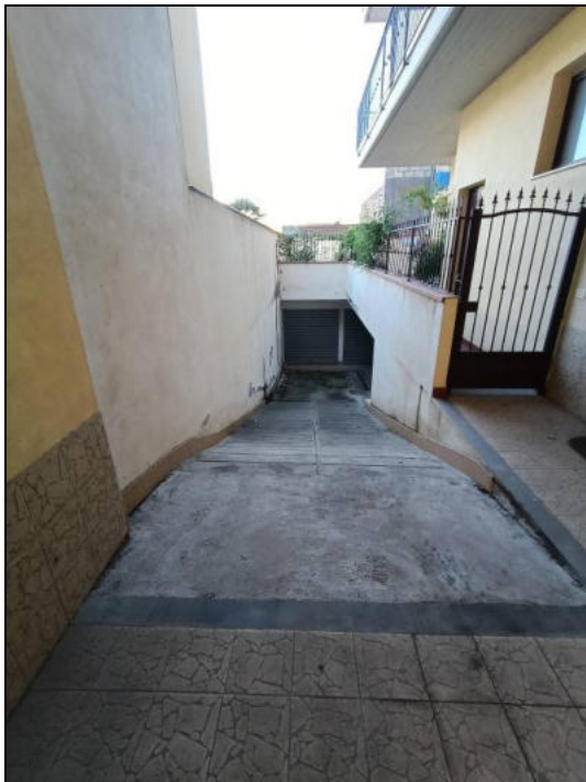
FOTO 3: Rampa di discesa al piano sottostrada.
