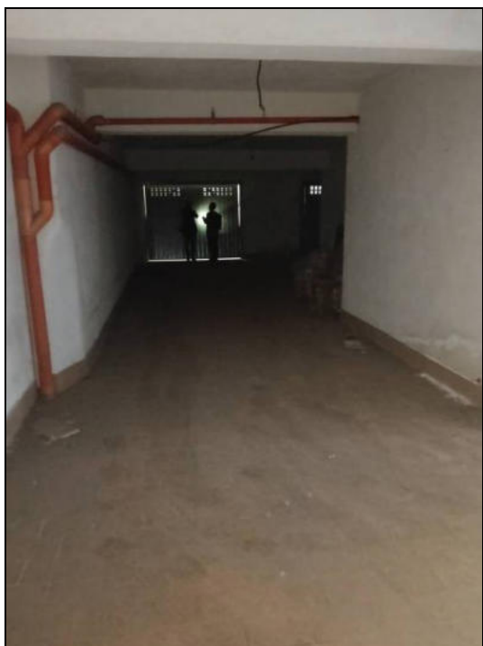
FOTO 5: Prosecuzione corsia garage al piano S1.
