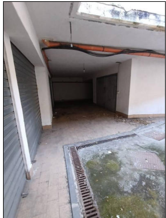
FOTO 4: Prosecuzione corsia garage al piano S1.
