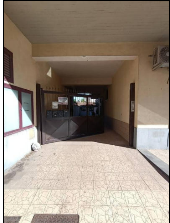
FOTO 2: Cancelli automatici per accesso rampa di discesa al piano sottostrada.
