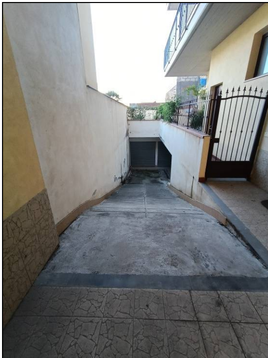
FOTO 3: Rampa di discesa al piano sottostrada.
