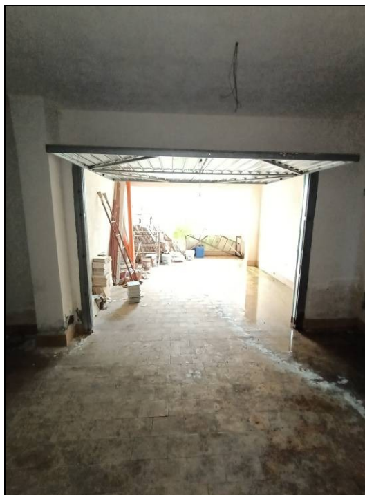
FOTO 6: Garage sub. 17, con apertura basculante.
