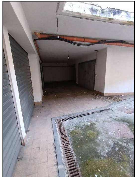
FOTO 4: Prosecuzione corsia garage al piano S1.
