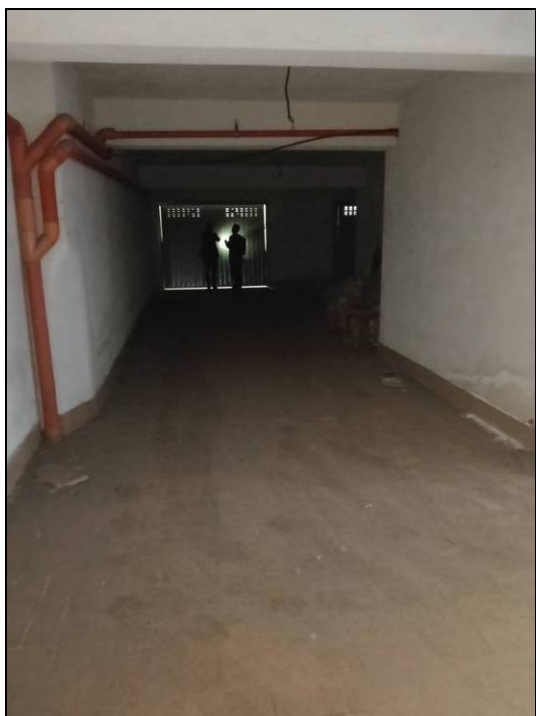
FOTO 5: Prosecuzione corsia garage al piano S1.
