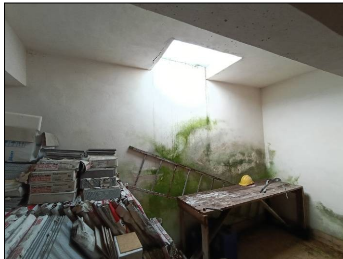
FOTO 10: Dettaglio apertura finestrata che da luce all'ambiente.
