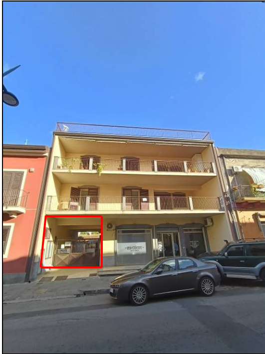
FOTO 1: Prospettiva del fabbricato ove si trova l'accesso carrabile per i garage siti al piano sottostrada.
