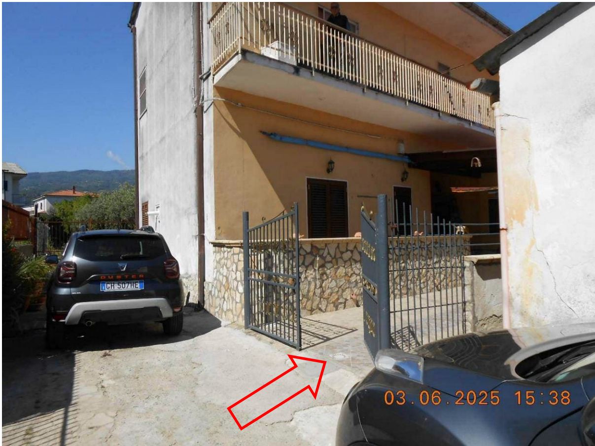
Accesso a p.lla 340
