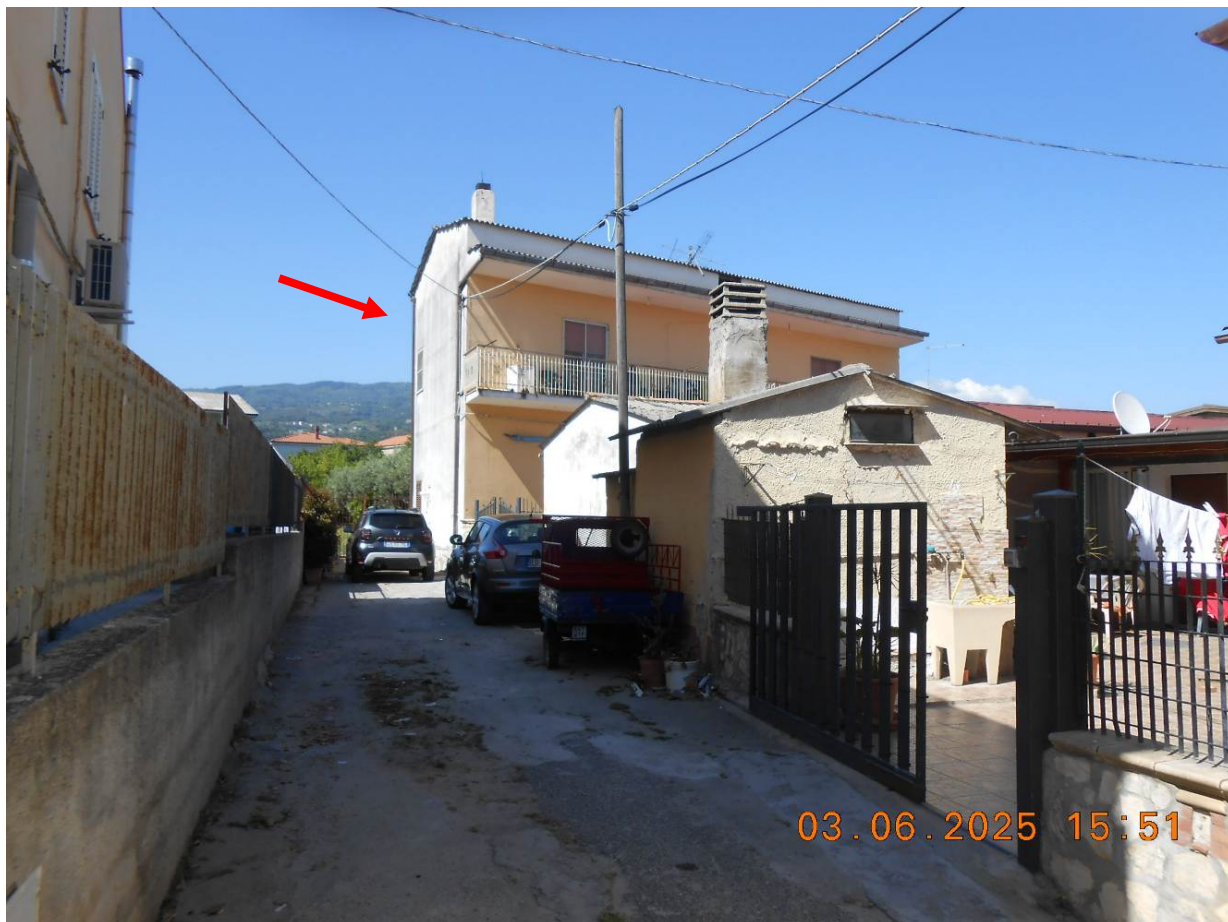
Foto n.1. Vista del fabbricato lato sud-est
