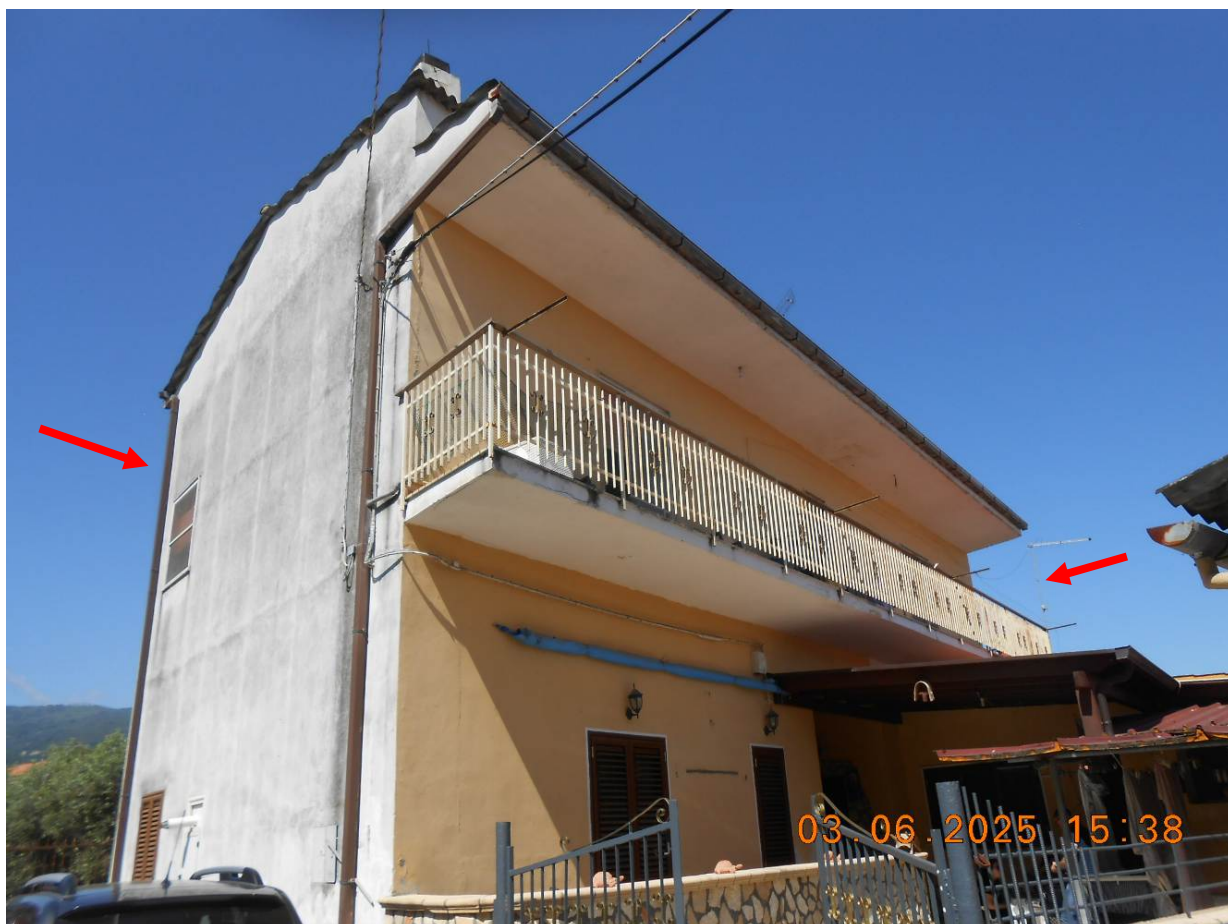
Foto n.2. Vista del fabbricato lato sud-est
