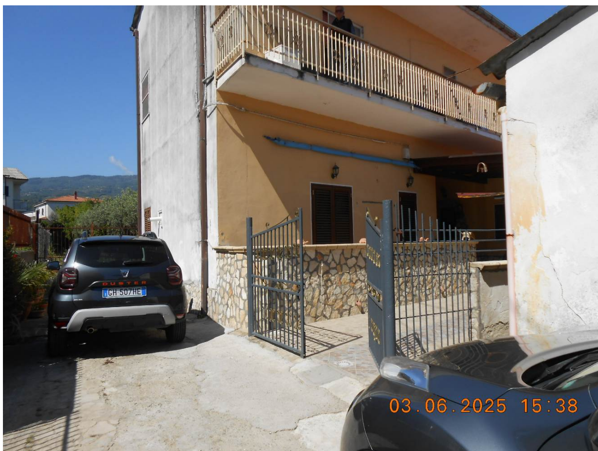
Foto n.24. Accesso al fabbricato da terreno p.lla 43 al terreno p.lla 340 da asservire
