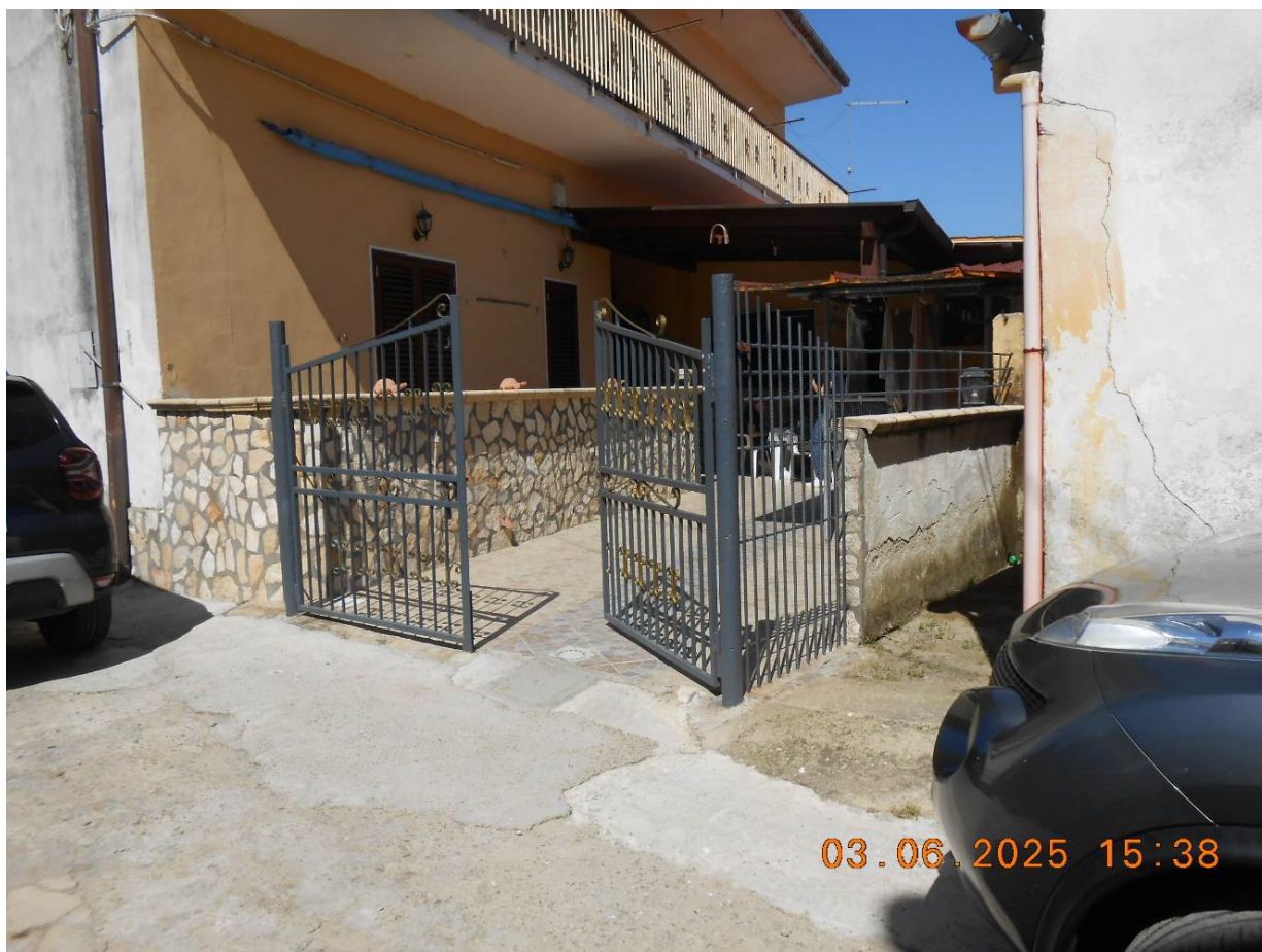
Foto n.25. Accesso al fabbricato da terreno p.lla 43 al terreno p.lla 340 da asservire
