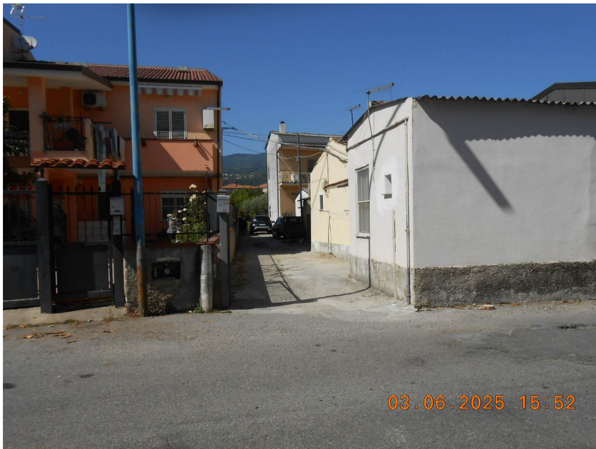
Foto n.21. Accesso al fabbricato da terreno p.lla 43 da via S. Foderaro
