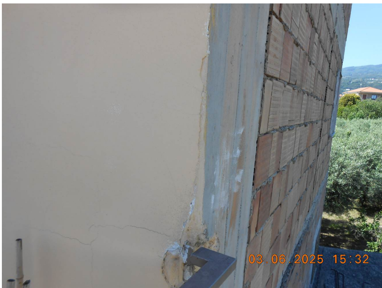
Foto n.20. Vista del fabbricato piano terra ovest
