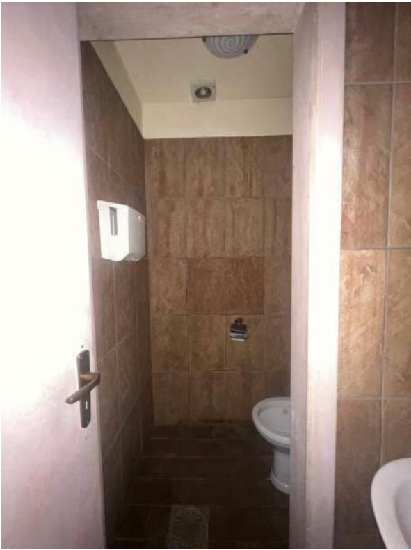
Dettagli servizio igienico avventori
