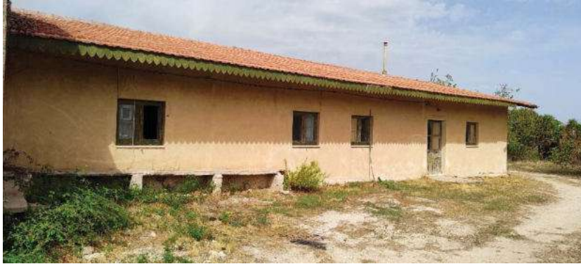
Foto 49 facciata sud casa custode
