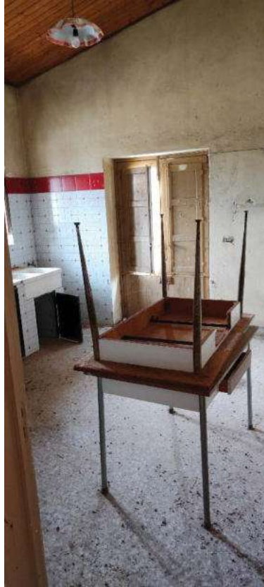
Foto 46 vano cucina casa custode
