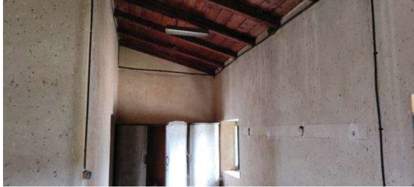
Foto 64 servizi per gli operai
