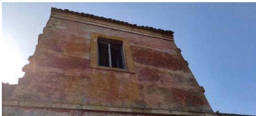
Foto 5: prospetto Nord piano primo
