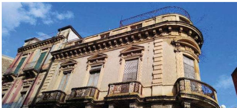
Foto 21: facciata lato Sud
