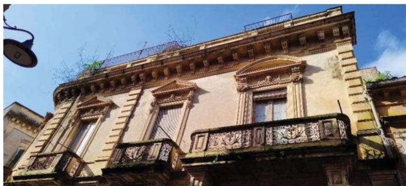
Foto 19: facciata lato Est
