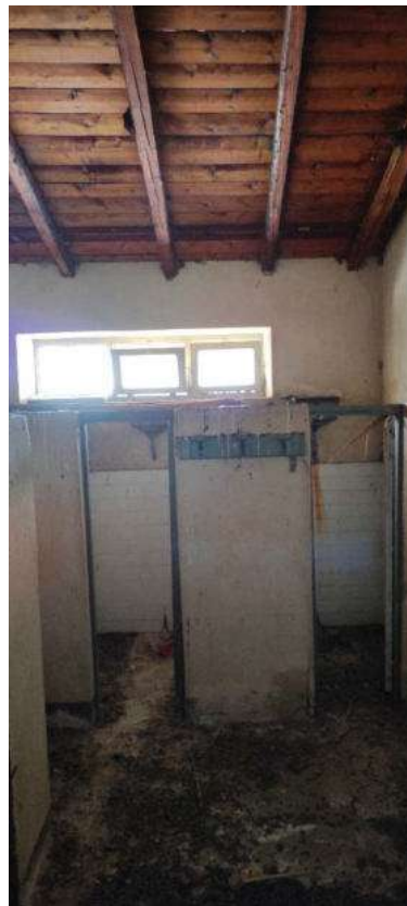
Foto 65 servizi per gli operai
