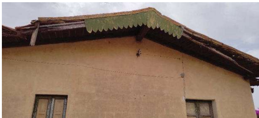
Foto 48 facciata Est casa custode
