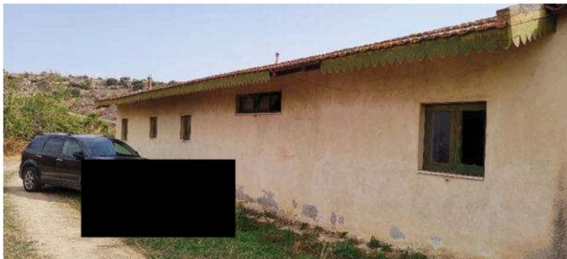
Foto 59 lato nord casa custode
