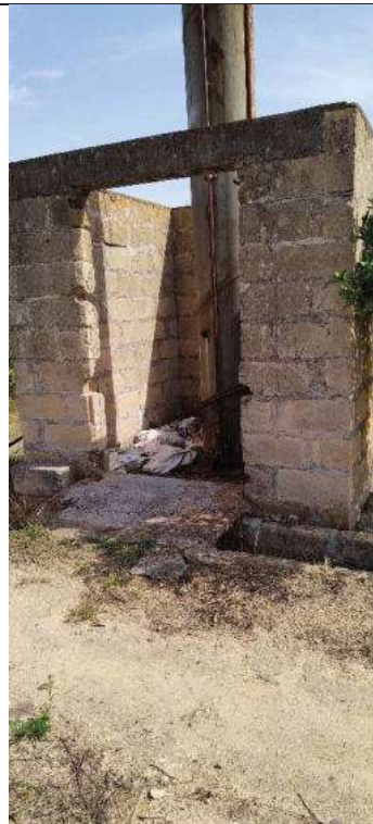
Figura 17: base pala eolica
