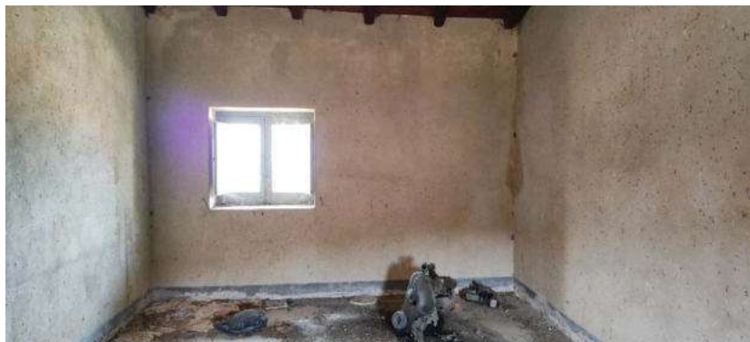
Foto 63 servizi per gli operai
