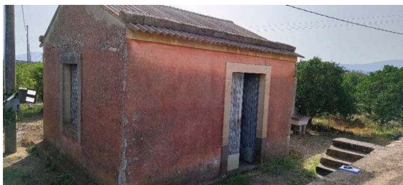
Figura 4 locale tecnico pozzo su p.la 190
