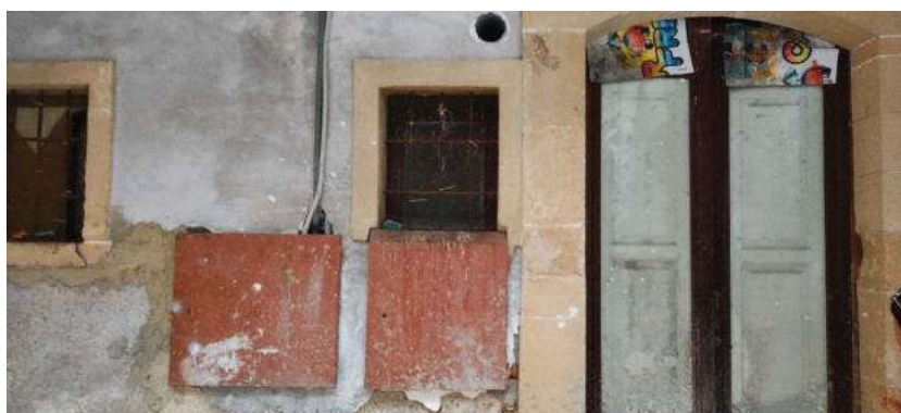
Foto 25: ingresso cortile vano secondario
