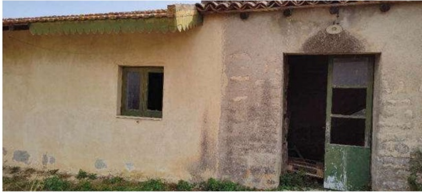
Foto 58 lato nord casa custode
