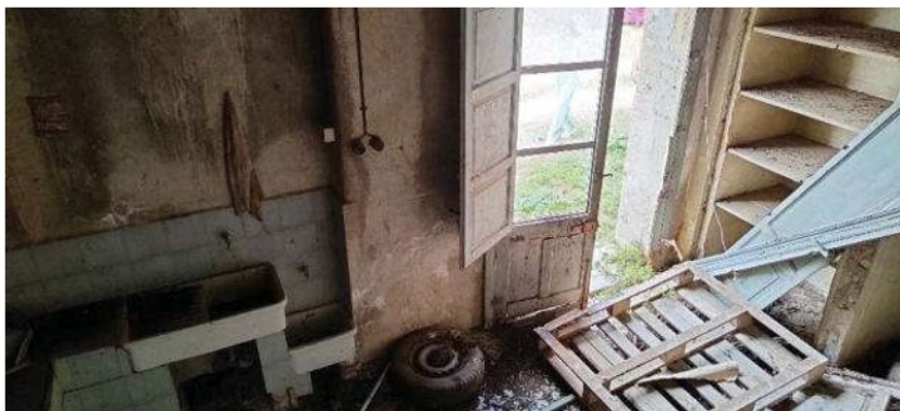
Foto 60 deposito lato nord
