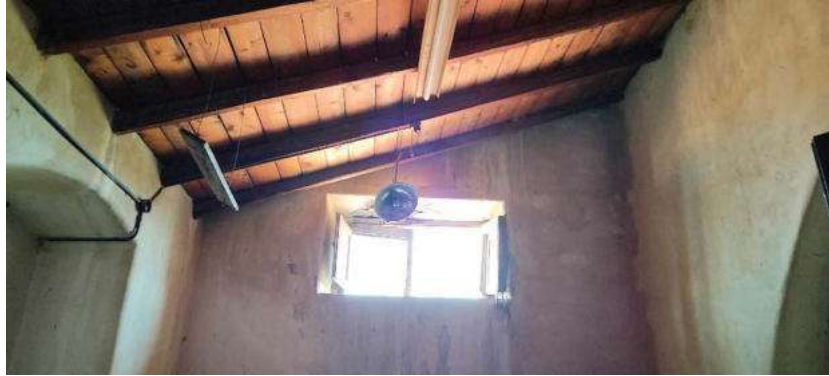
Foto 61 servizi per gli operai
