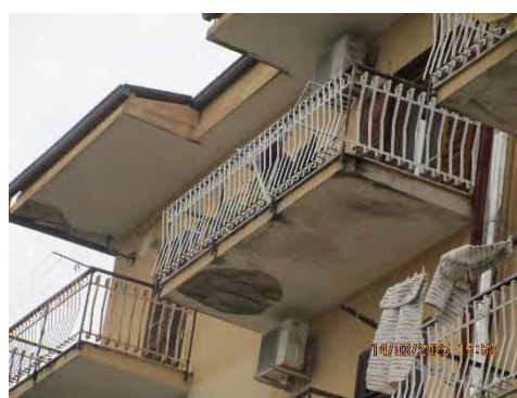
Foto n. 9 – Sottobalconi prospetto ovest
