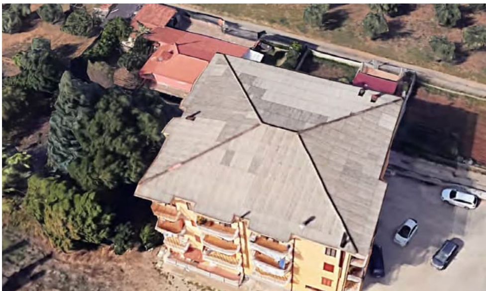
Fig. n. 5 – Copertura fabbricato ospitante il bene pignorato
