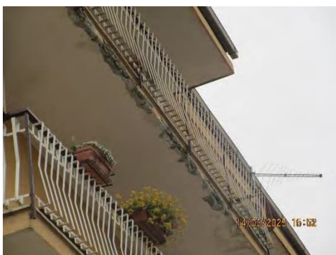
Foto n. 10 – Sottobalconi prospetto sud
