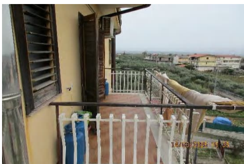
Foto n. 22 – Particolare balcone sud
