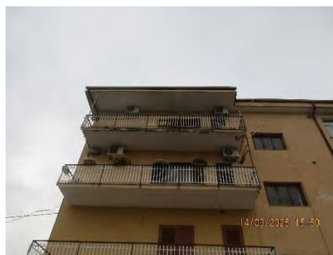
Foto n. 11 – Sottobalconi prospetto sud
