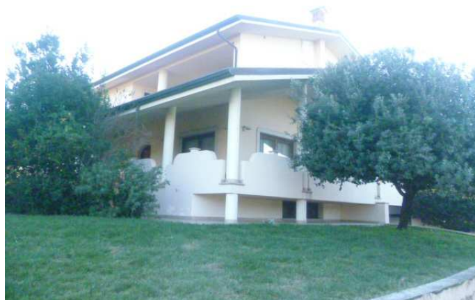
Vista Lato Nord -Ovest
