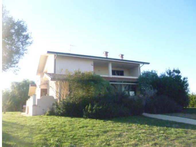
Vista Lato Nord
