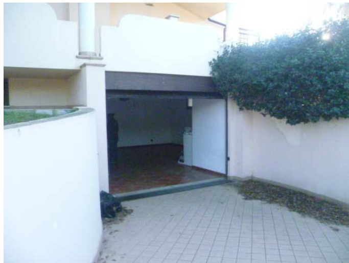
Accesso Piano Interrato
