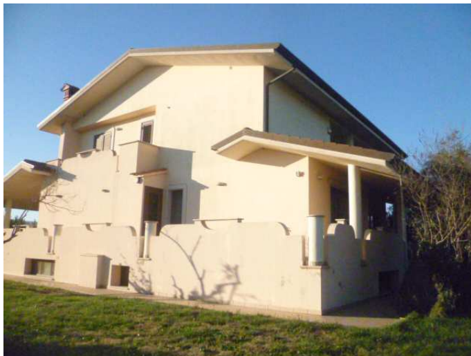
Vista Lato Est
