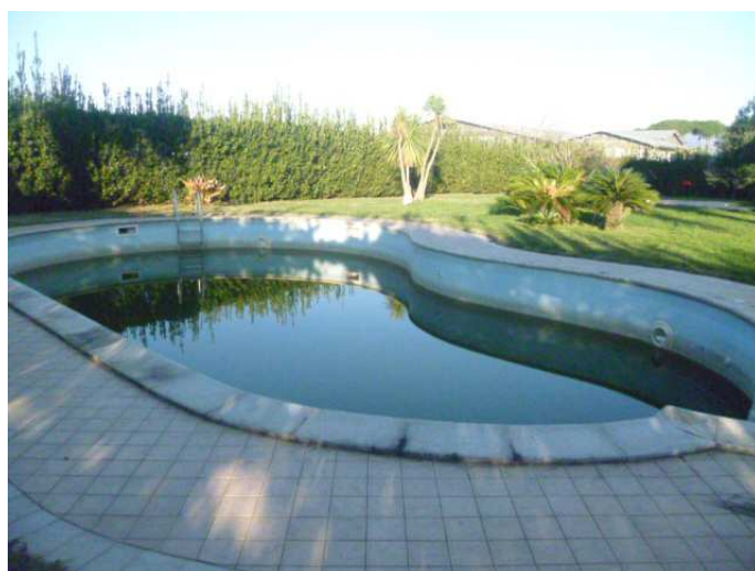
Vista piscina ( oggetto di ripristino)
