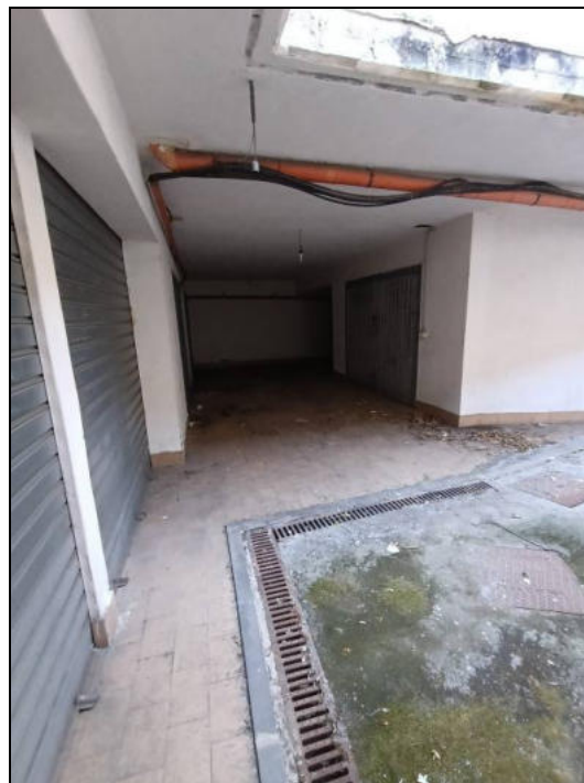
FOTO 4: Prosecuzione corsia garage al piano S1.
