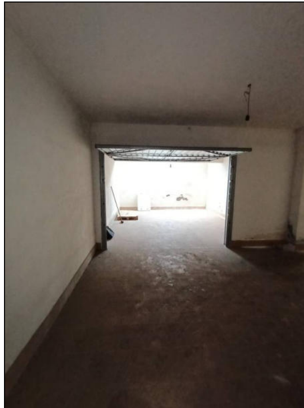
FOTO 6: Garage sub. 16, con apertura basculante.
