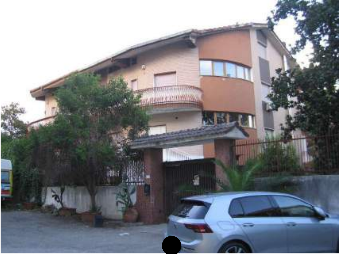
Foto n° 1 - Vista esterna dalla Traversa Sandro Botticelli
