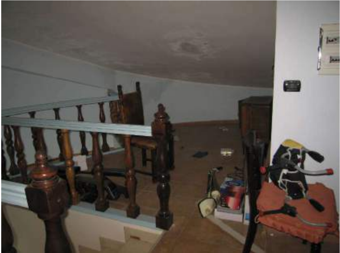
Foto n° 41 e 42 - Vano sottotetto (Piano Terzo)
