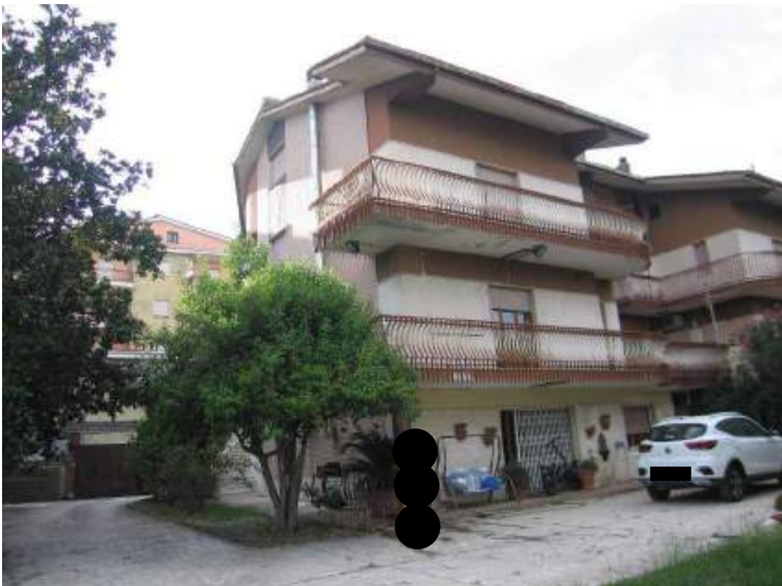
Foto n° 2 - Vista esterna dalla corte comune
